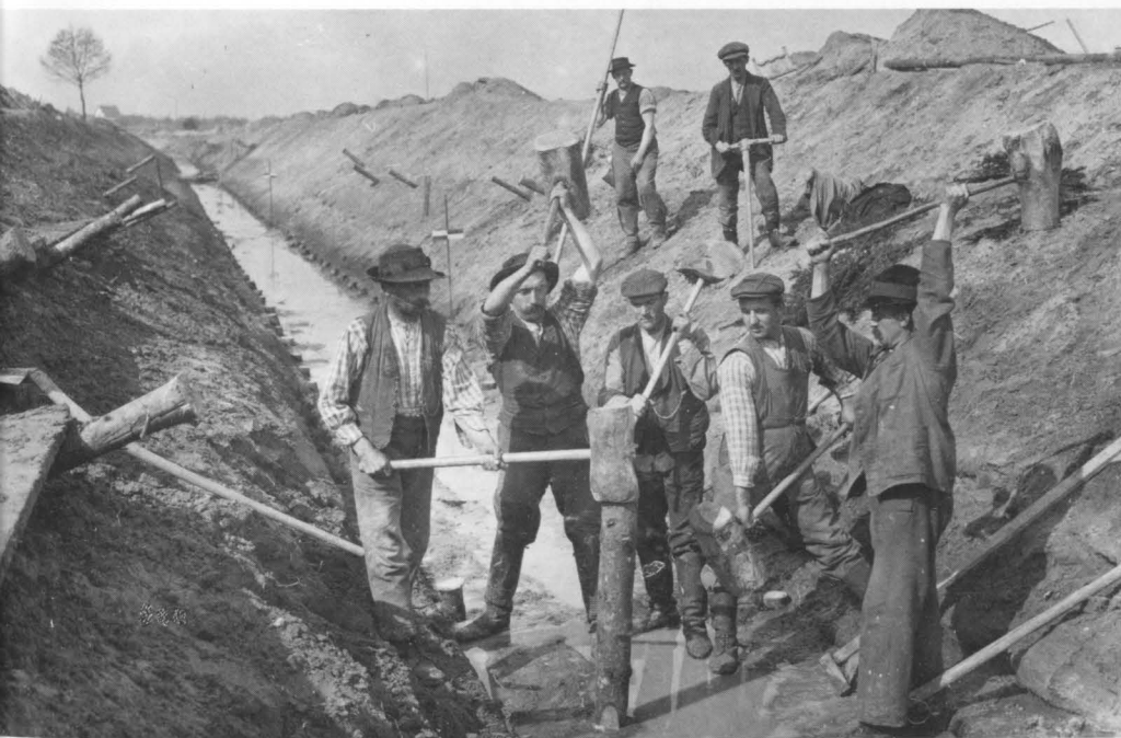
Die Zimiker beim Kanalbau 1918, Guntenbach bei Erlenwiesen
