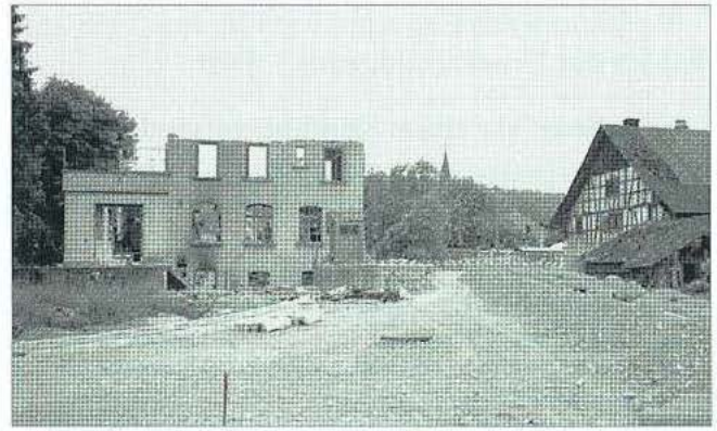
Die Ringstrasse im Bau; Blick Richtung Badenerstrasse
