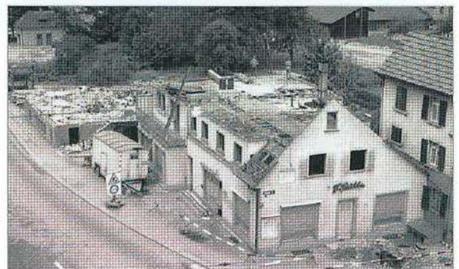
... die alte «Schmitte» und das Haus Bahnhofstrasse 1
