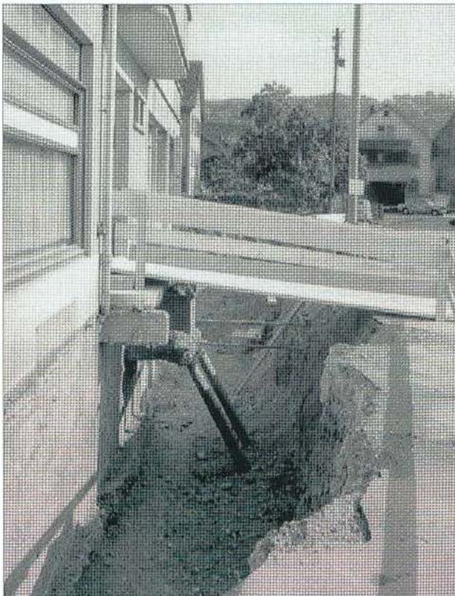
Erst musste das Fundament freigelegt und auf Höhe der Kellerdecke von den Hausmauern getrennt werden.
