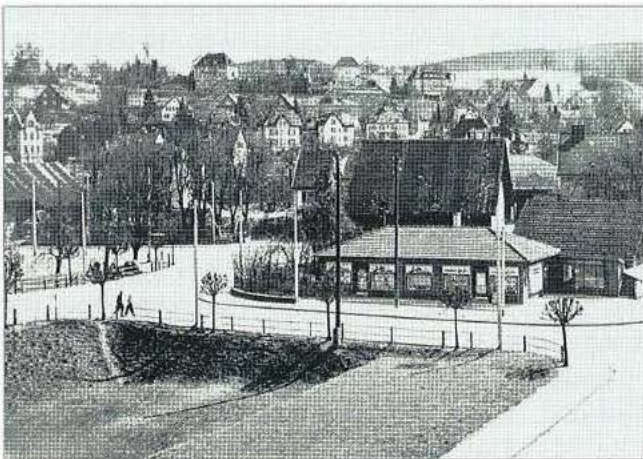
Das Provisorium der Drogerie Locher
