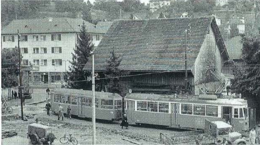
Der Ausbau der Tramschleife war u. a. nötig geworden, weil die StStZ wegen der grossen Passagierzahlen Tramzüge mit den neuen, vierachsigen Anhängern führen musste. Anstelle der Baugrube stand früher die erste Drogerie Locher.
