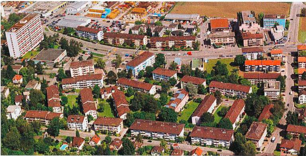
Das «Nassacker»-Quartier zwischen Kesslerplatz und Nassackerstrasse einerseits und Urdorfer- und Baderstrasse andererseits
