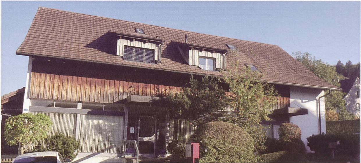
Abbildung 113: Der ehemalige Volg Hüttikon, in dem heute das Architektur-Büro «Schönmann-Walder-Ronc Architekten AG» untergebracht ist. (Foto: Sabine Moser-Schliier)
