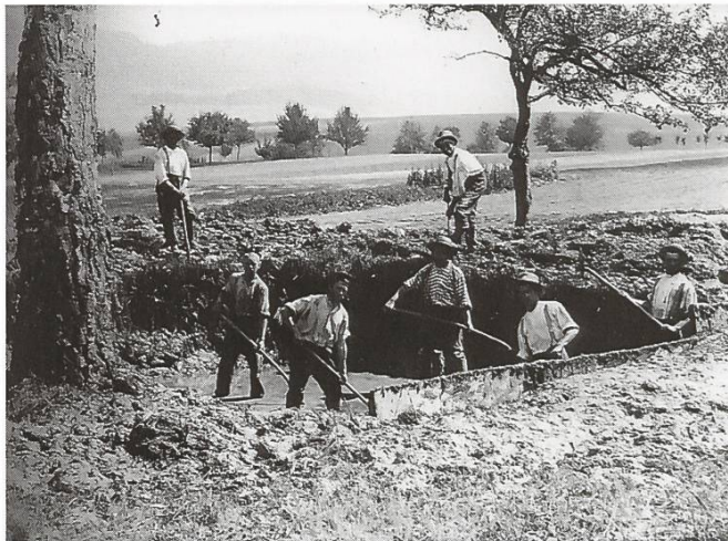
Abbildung 45: Grabenarbeiten für den Feuerwehrweiher unterhalb der Chriesbaumstrasse, undatiert (Quelle: Käthi Chapuis-Güller, Val Thorens, Frankreich)
