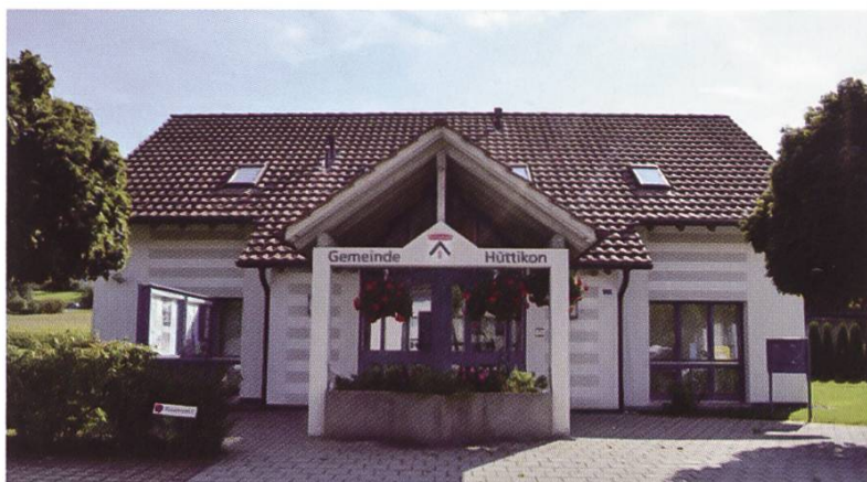
Abbildung 42: Das neue Gemeindehaus an der Zürcherstrasse 22
