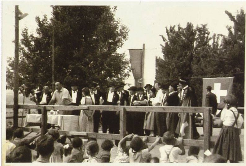
Abbildung 139: Festansprache von Albert Markwalder auf der mit Brettern und Balken errichteten Holzbuhne (Quelle: Walter Markwalder, Huttikon)
