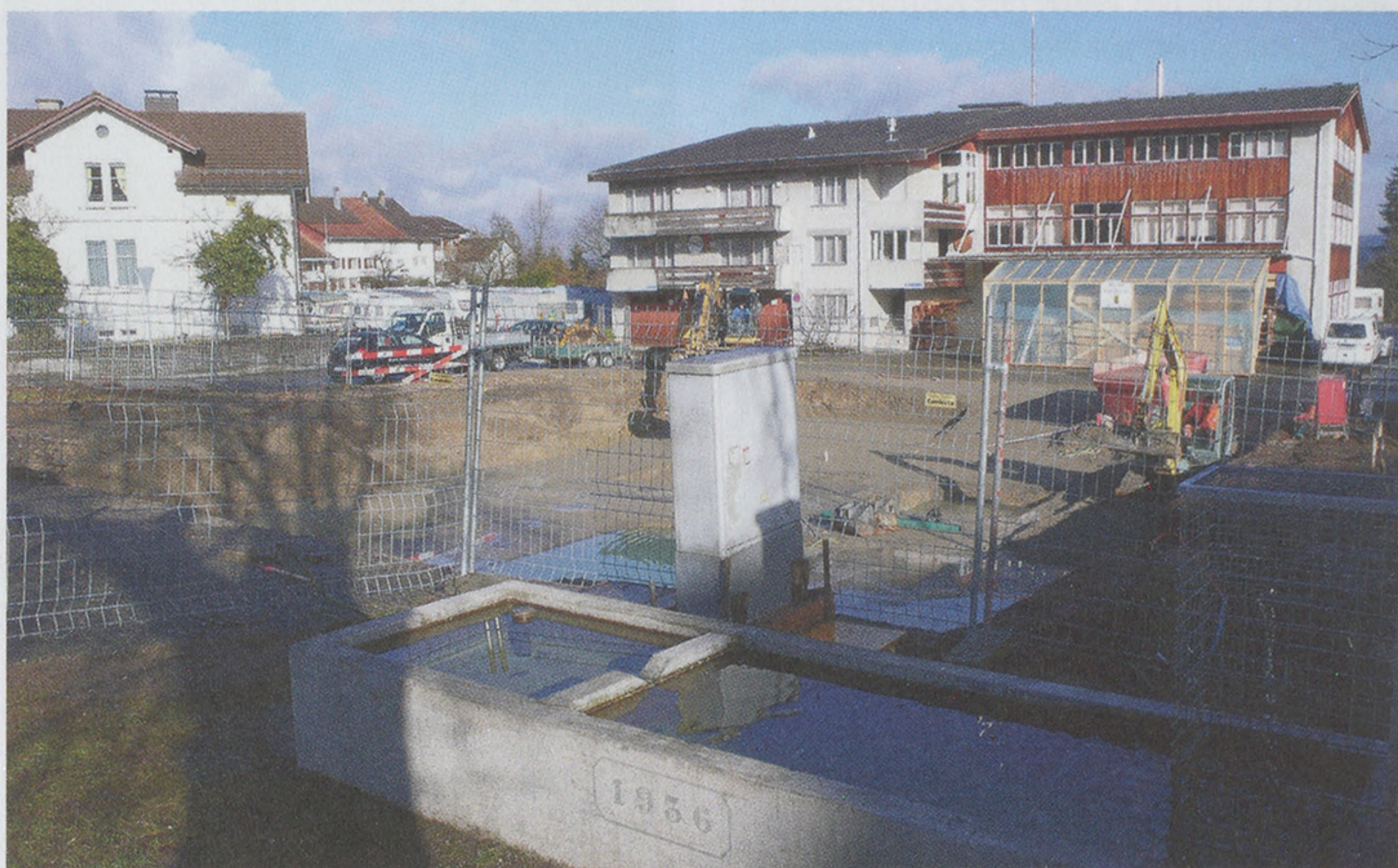
Mitten in Maur, an der Kreuzung Reilkon-/Zürichstrasse ist Haus und Baum gewichen und die Bauarbeiten mit dem Aushub sind in vollem Gange. (Foto: Sandro Pianzola)
