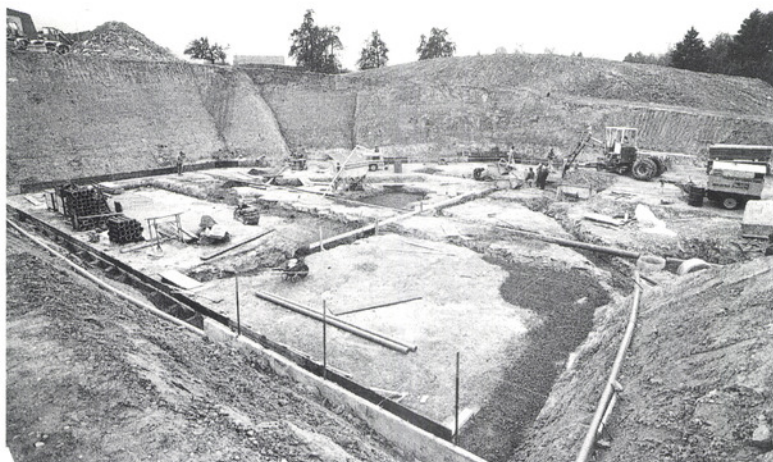
Noch leere Baugrube...
