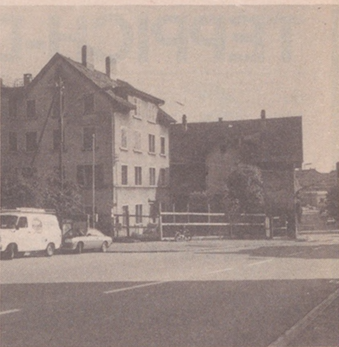
Im Dreieck an der Bauherrenstrasse, der Strasse Am Wasser und dem Tobeleggweg stehen zurzeit vier Häuser leer. Ihre Tage sind gezählt — der Abbruch steht bevor. Nachdem vorerst eine Renovation in Betracht gezogen wurde, fiel der Entscheid schlussendlich doch auf eine Neuüberbauung mit Woh-nungen. Am Wasser, vis-à-vis Restaurant Freihof, ragt ein Haus stark hervor (Bild rechts). Dieses Ge-bäude wird ebenfalls weichen — eine übersichtlichere Strassenführung wird zurzeit ausgearbeitet, je-doch liegen noch keine konkreten Vorschläge vor. Ob die provisorische Blinklichtanlage bestehen bleibt, oder eventuell eine andere Lösung gesucht wird, darüber wurde noch nicht entschieden. Hof-fen wir, dass der gefährliche Abschnitt gut saniert wird, denn die doppelte Sichtbehinderung Kurve sowie Höhendifferenz waren für alle Verkehrsteilnehmer eine Belastung, besonders aber für die Fuss-gänger.
