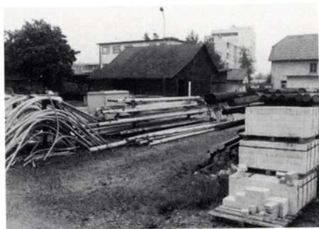
Der hinter den Werkgebäuden erstellte Lagerplatz für das grosse Material besteht seit 1961.
