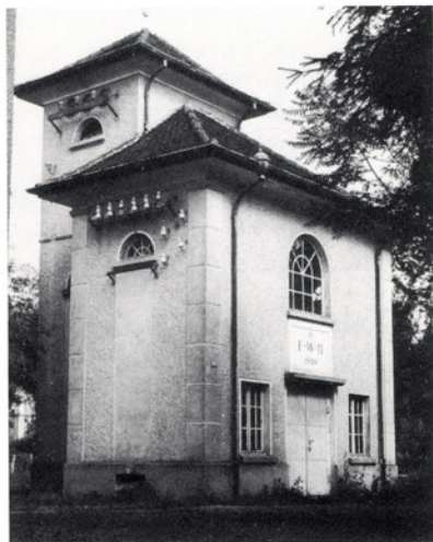
Die 1926 in der Nähe der Glattbrücke an der Bahnhofstrasse erstellte Transformatorstation Ost.
