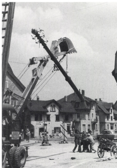
Abbruch der alten Freileitungen an der Zürichstrasse im Jahre 1962.
