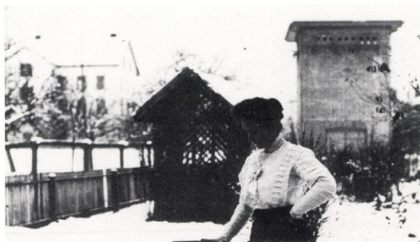
Die erste Transformatorstation in unserer Gemeinde, die 1905 in der Nähe des Schulhauses Dorf B entstanden war.
