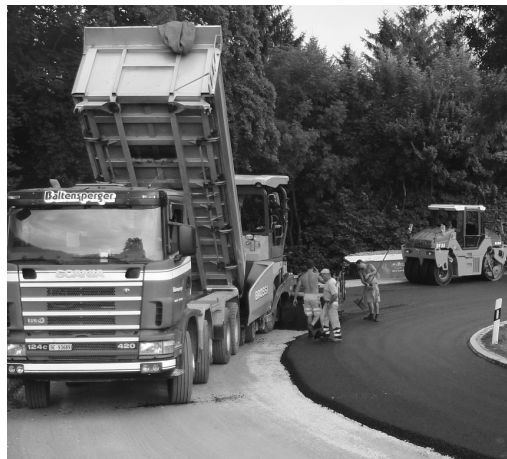
Sanierung der Poststrasse in Winterberg.
