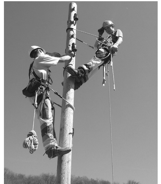
Unser Lernender Netzelektriker Daniel Keller beim setzen von Isolatoren anlässlich einer Übung in der Berufsschule.
