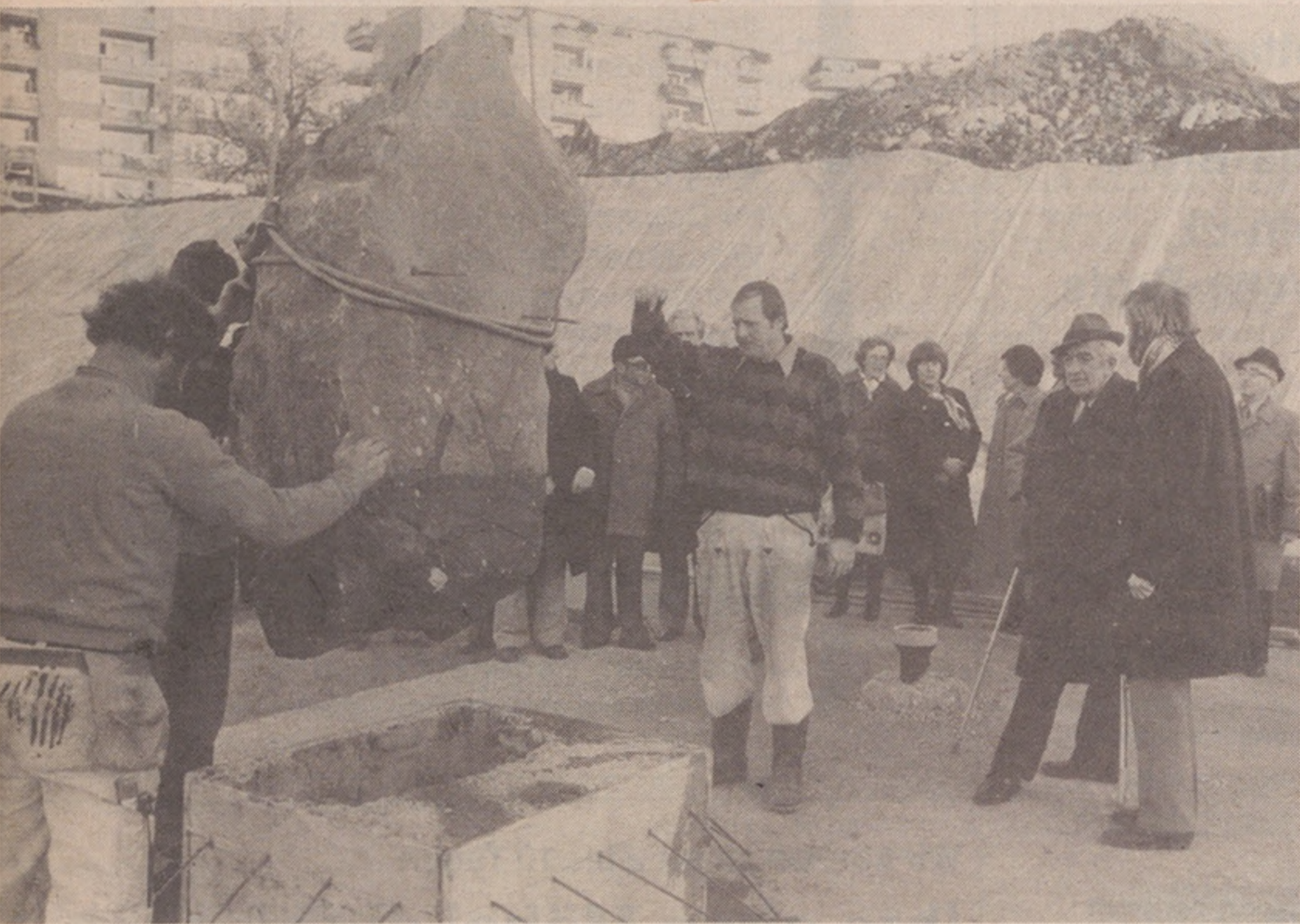
Unter den Anweisungen des Bauführers setzte der Kranführer den roten Ackerstein geschickt auf den vorbereiteten Sockel. Der pyramidenförmige Findling wird nach Fertigstellung der Bauten zur Hälfte aus der Kellerwand ragen. Eine Bronze- tafel mit Inschrift wird an das denkwürdige Jahr erinnern, wo der Bau des Alterswohnheims in Höngg seinen Anfang nahm.
