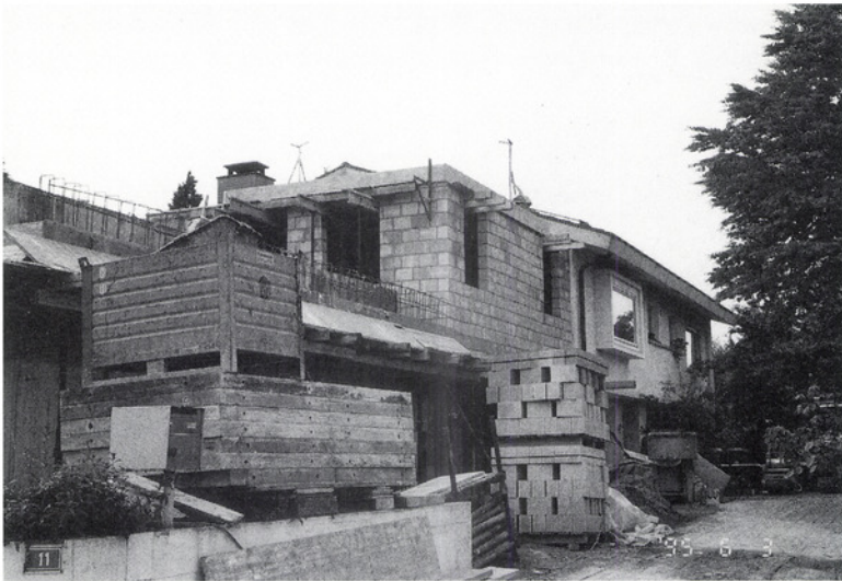
Anbau eines Einfamilienhauses an ein bestehendes Gebäude.
