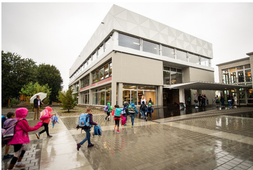
Am ersten Schultag strömen die Schüler bei strömendem Regen in den sanierten und aufgestockten Trakt A des Schulhauses Hellwies. Bild: Seraina Boner
