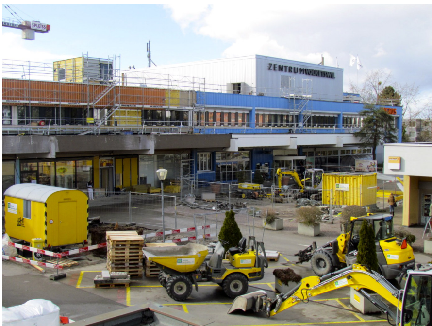
Vor dem Einkaufszentrum wird noch auf Hochtouren gearbeitet: Der „Zänti“-Platz wird begrünt und mit Sitzmöglichkeiten ausgestattet. Bild: Toni Spitale
