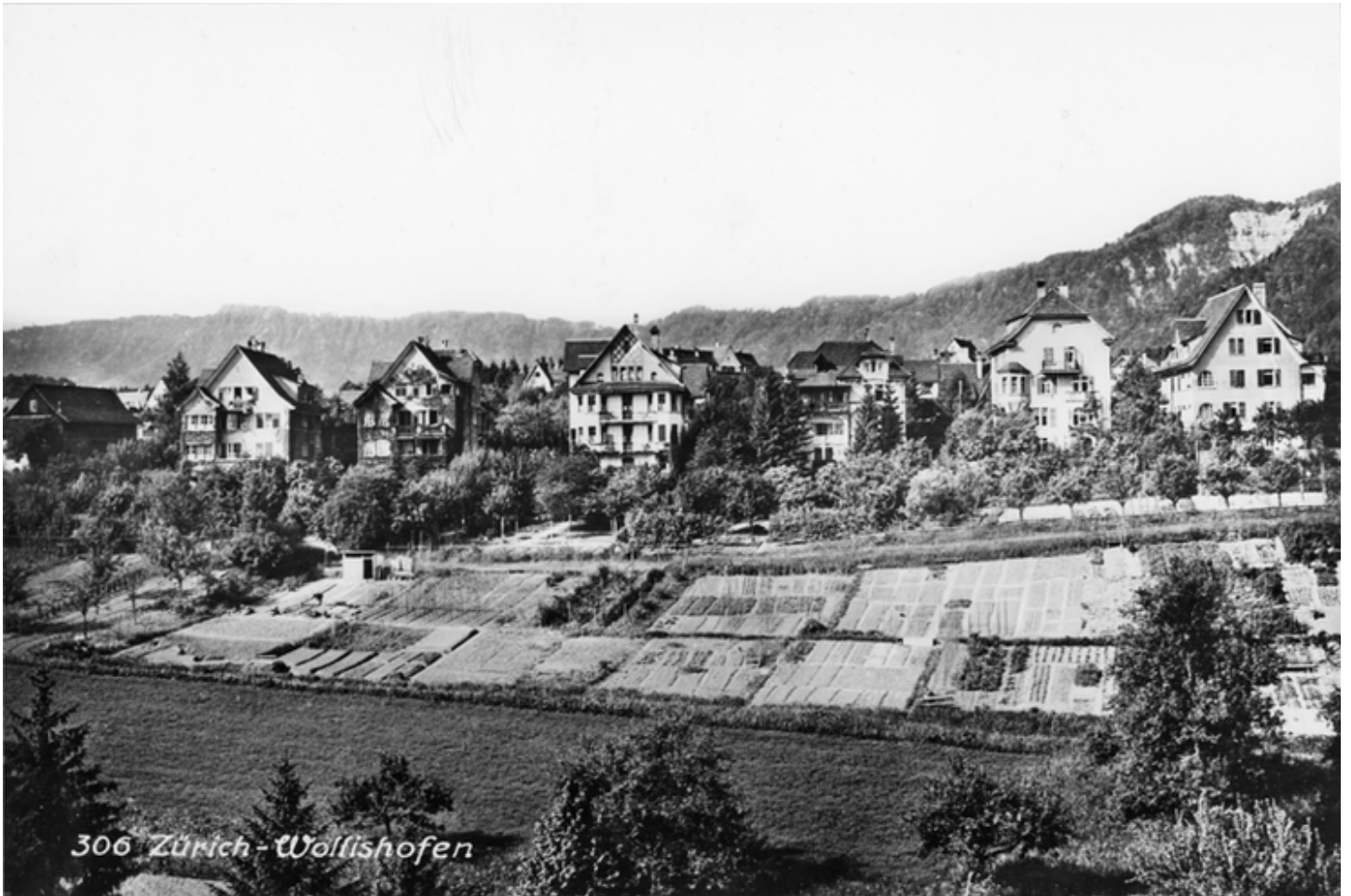
Rainstrasse 22-32. Mit herrlichen Gärten (wo einst Rebberg war)! Fotograf Heinrich Wolf-Bender, ca. 1920. Baugeschichtliches Archiv Zürich.
