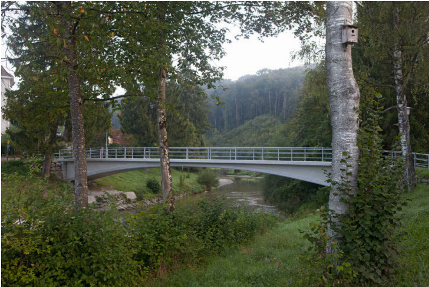
2011 wurde der Wunsch nach Ersatz der Schöntalbrücke (29) laut. Dank einem ingenieurtechnisch anspruchsvollen Massnahmenkonzept gelang 2015–2016 die denkmalgerechte Sanierung.
