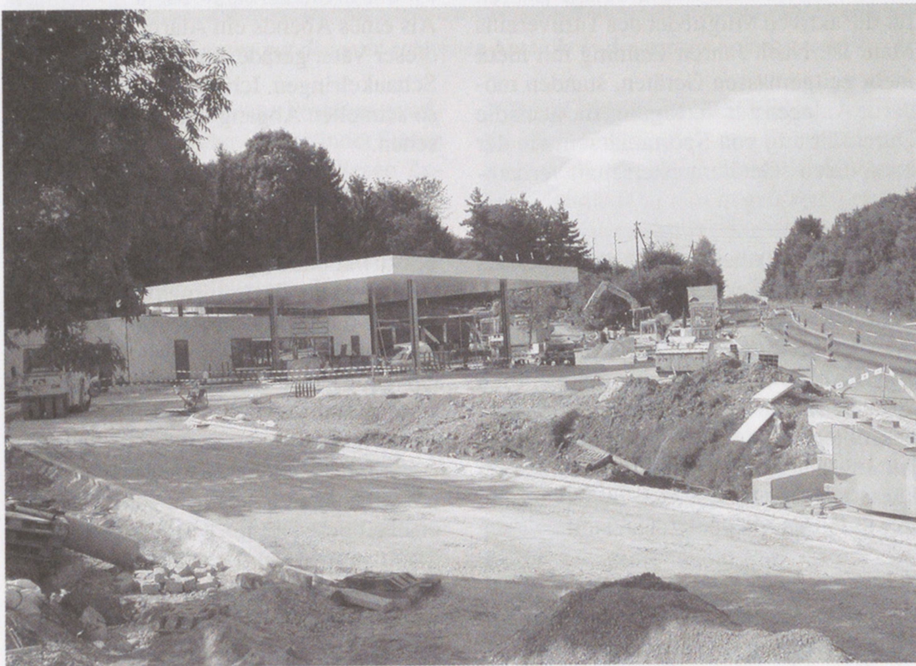
Letzte Bauarbeiten am Rastplatz Heuberg West, von Hinteregg aus gesehen
