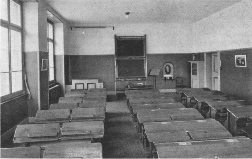
Klassenzimmer 1914 (Foto Baugeschichtliches Archiv der Stadt Zürich)
