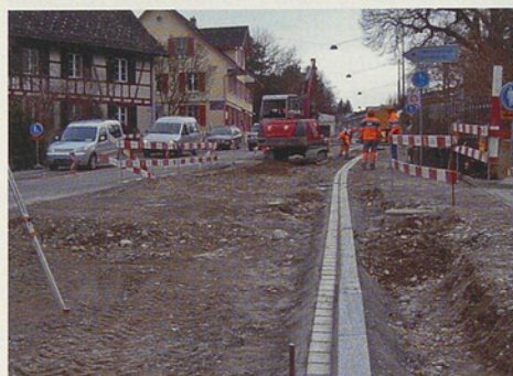
Erneuerung Strassenabschlüsse Abschnitt Kanzleistrasse bis Rössligasse
