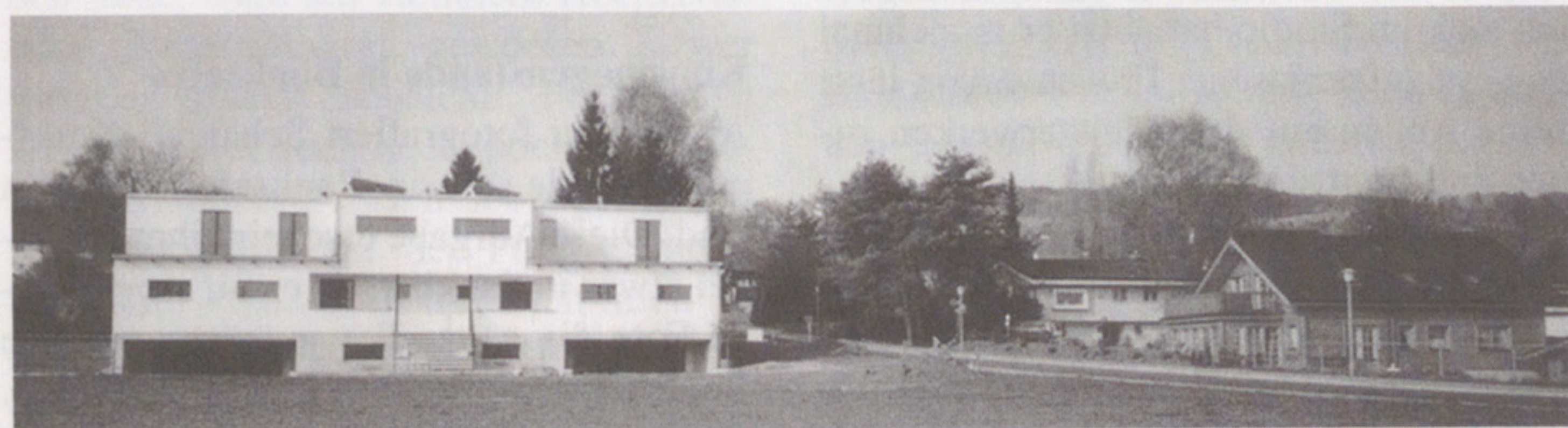
Diese zwei Häuser oberhalb der Schifflande sind von der gleichen Behörde im gleichen Jahr bewilligt worden und stehen am Bauzonen- und zugleich am Greifenseeschutzzonenrand. Wie cha mer au!
