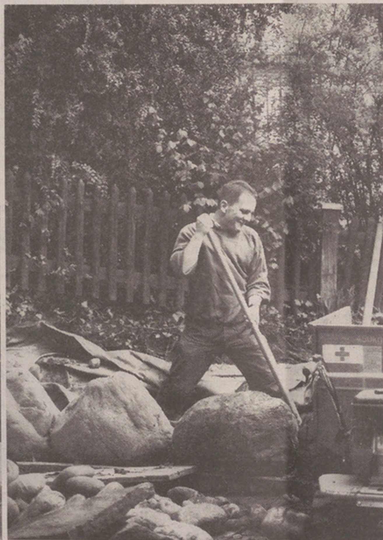
Hier entsteht ein Biotop. Die zum Auslegen des Grundes benötigte Plastikfolie sowie schwere Findlinge für den Teichrand liegen bereit.
