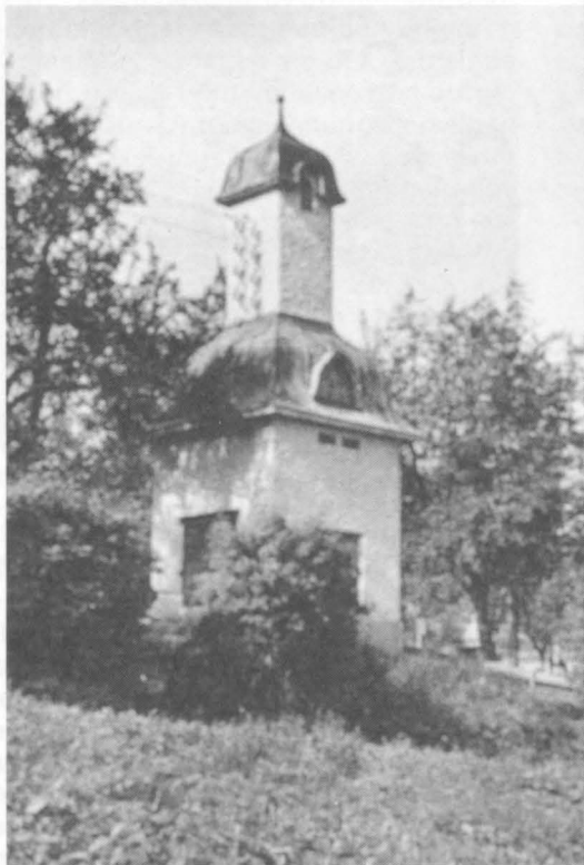
Gemauerte Transformatorstation wie sie in Hegnau an der Strasse nach Schwerzenbach erstellt wurde.
