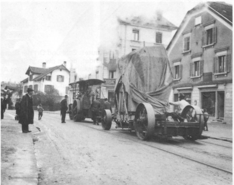
Schwertransport eines Transformers mittels Dampfwalze 1918
