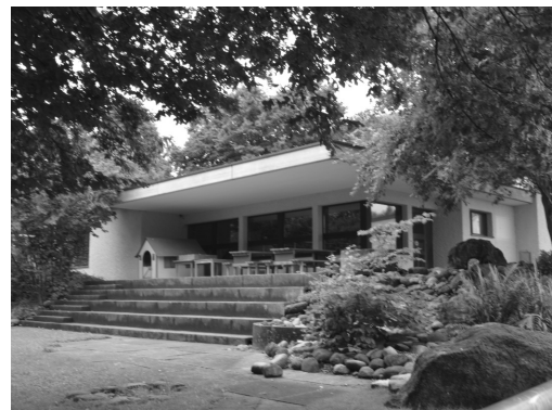
Der Kindergarten Grafstal erhält eine neue Aussenanlagen.
