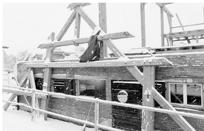
Einer von dreien: ein Dachbinder steht abholbereit auf der Seite.
