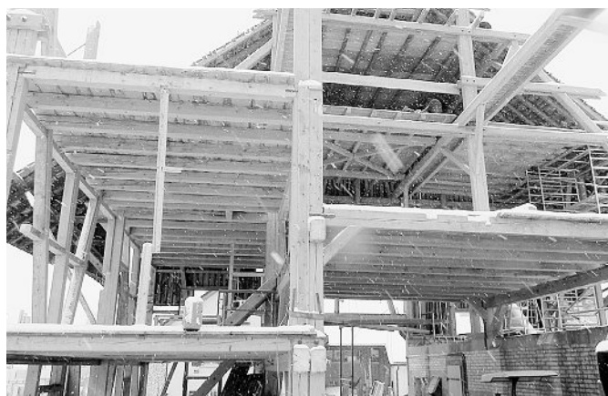
Die Balkenlagen sollen möglichst originalgetreu für den Neubau wieder eingesetzt werden. (Fotos: cl)
