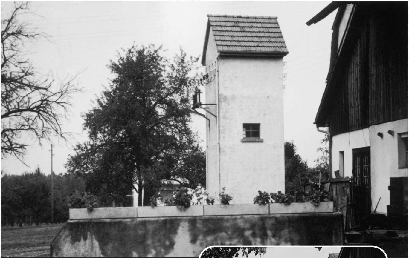
Pfaffhausen 4 Mit der Einführung der Elektrizität in Pfaffhausen musste 1910 eine Turmtrafo- station errichtet werden. Sie stand bis 1967 an dem Ort, wo sich heute die Glassammelstelle befindet.
