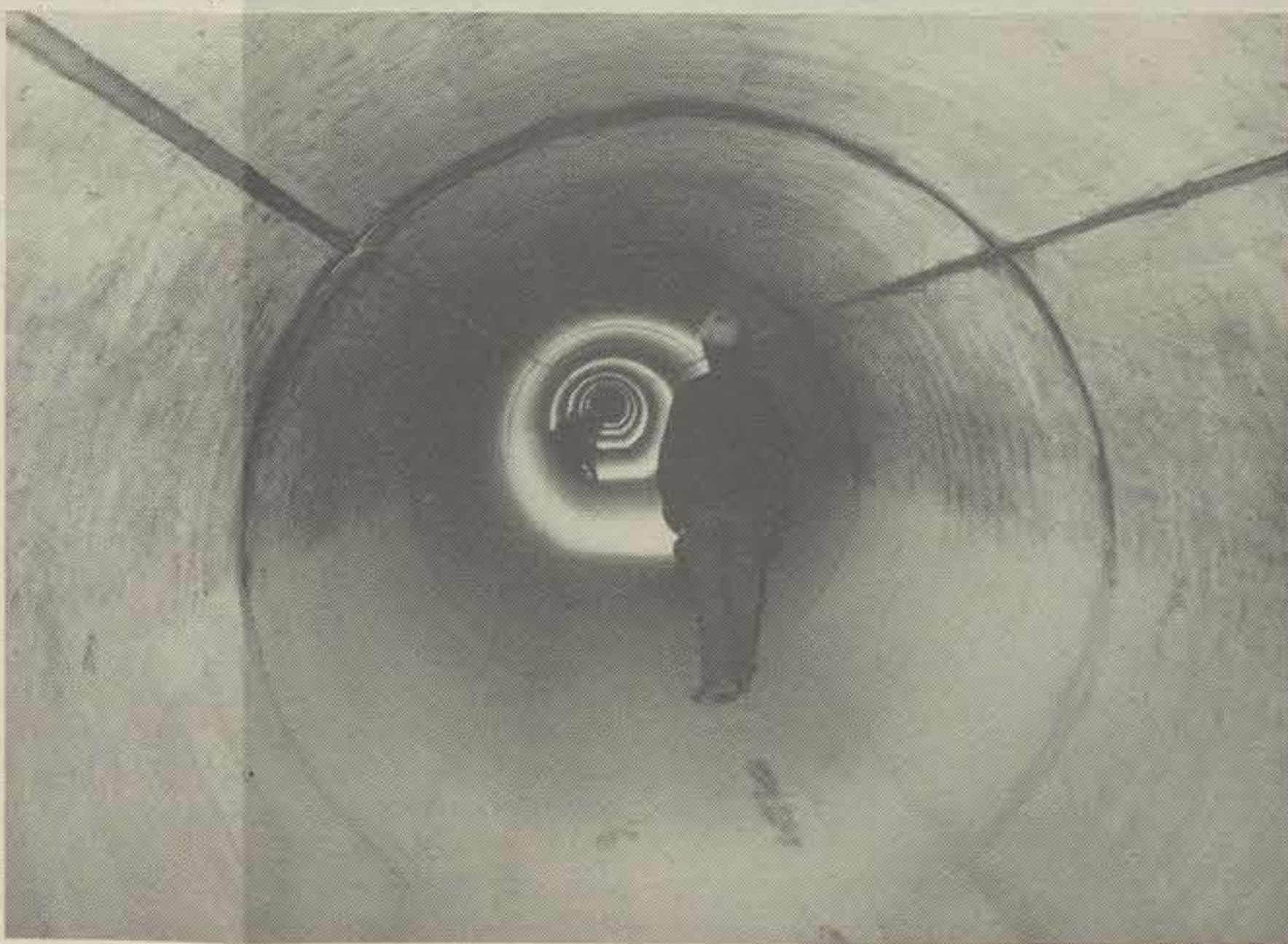
Im Trinkwasserstollen Käferberg (Länge 4,46 km, innerer Durchmesser: 2,14 m)
