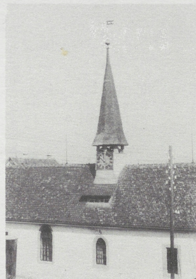
Abbildung 7 Dachreiter auf der Kirche Fällanden
