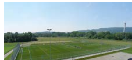
Der Kunstrasenteppich wird verlegt
