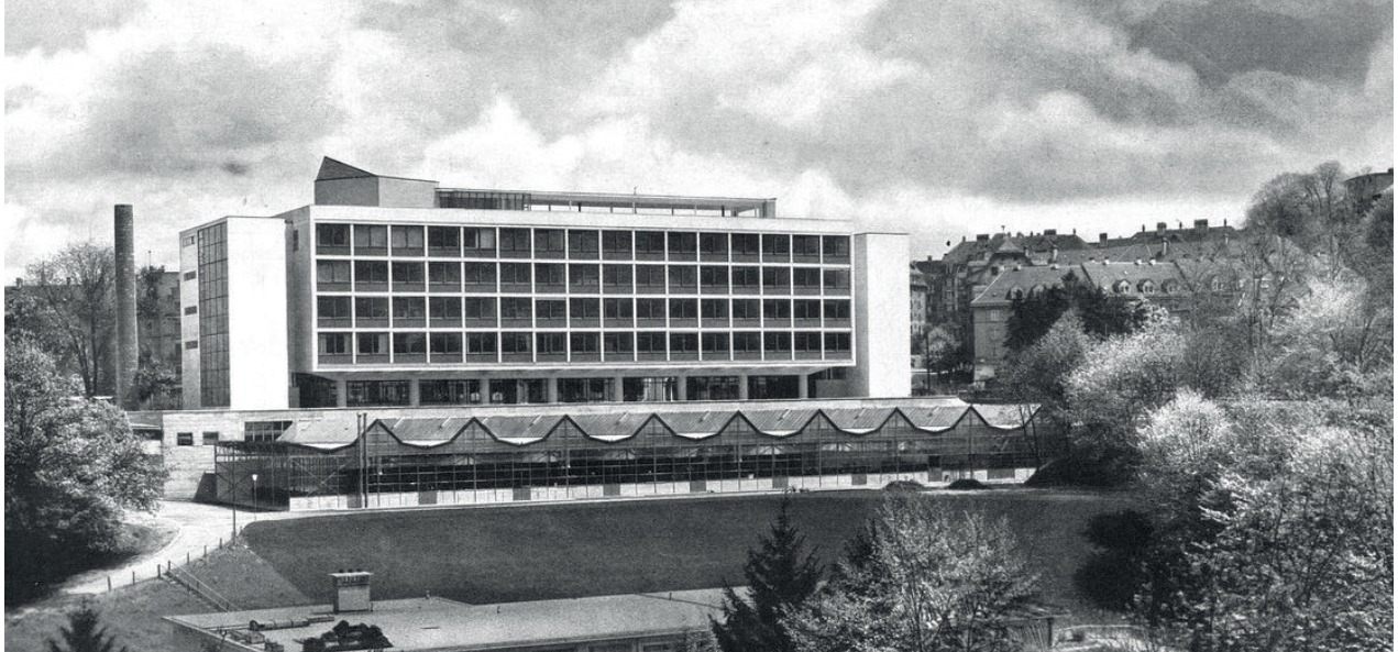
Im Jahr 1939 – im Jahr der Mobilmachung also – wurde die „neue Gewerbeschule“ in der Lorraine eröffnet (Architekt Hans Brechbühler). Dieses hochmoderne und städtebaulich avantgardistische Gebäude signalisierte die zunehmende Wichtigkeit der beruflichen Grundbildung. Im Sommersemester 1939 besuchten 2116 Lernende die Gewerbeschule Bern an nunmehr vier Standorten in der Stadt. (graberpulver.ch)
