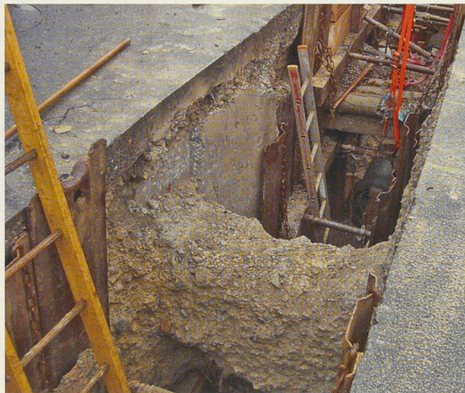
Werkleitungsbehinderungen im Grabenbau
