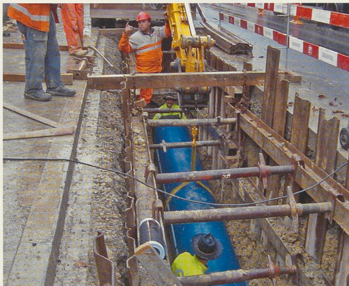
Verlegung der Wasserleitung DN 700
