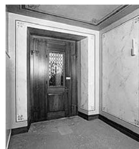
Korridor im Erdgeschoss nach der Renovation. Zustand 1994. Nachdem grosse Teile der Wandoberflächen beschädigt worden waren, so dass auf eine Freilegung verzichtet werden musste, wurde die Marmorierung der Wände – ausser einem freigelegten Referenzfeld – neu angebracht.
