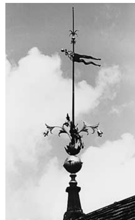
Der Blitzableiter wurde re-stauriert und nach Befund mehrfarbig gefasst. Vor der Restaurierung. Zustand 1989.
