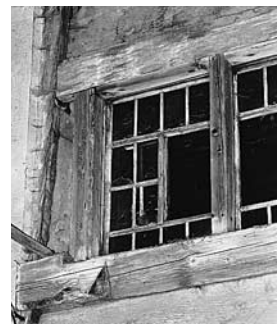
Originales Doppelfenster an der rückseitigen Bohlenständerfassade, vor der Renovation. Zustand 1987. (Vgl. Bild unten).
