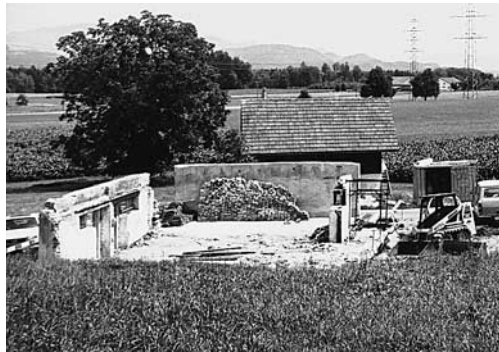
V.l.n.r.: Zustand am 12.5.1991/zwei Abbau-Etappen am 26.5.1992/ Zustand am 8.11.1992. Zwei Aussenmauern blieben erhalten, die Nordmauer (Vordergrund) stürzte bei der Neufundierung ein. (Siehe Legende links und Bilder unten).
