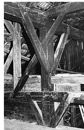
Dachkonstruktion über der Wand zwischen Tenn und Wohnteil. Photo M. Flachsmann, IGA, 1991.
