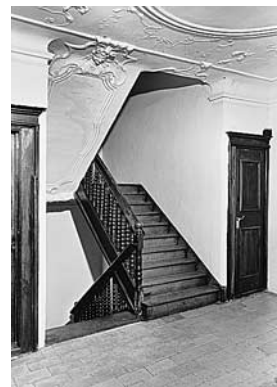
Treppenhaus und Korridor im 1. Obergeschoss. Zustand 1971.
