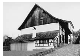
Scheune und Trotte nach der Renovation. Zustand 1998.
