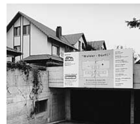
Teilansicht der 1994–1996 neu erstellten Werksiedlung. Das neue «Walder-Dörfli» steht auf einer Betonplatte, unter der sich die Tiefgarage befindet. Zustand 1998.
