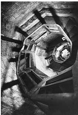
Das Innere des Kirchturms. Zustand 1997.
