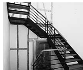
Das neue Treppenhaus mit Stahlterasse im nördlichen Anbau von 1802. Zustand 1993. Im Hintergrund ist die ehemalige Nordfassade des ursprünglichen Baus sichtbar. Vgl. Plan unten.
