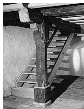
Holzpfiler im Kellergeschoss nach der Renovation. Zustand 1994.
