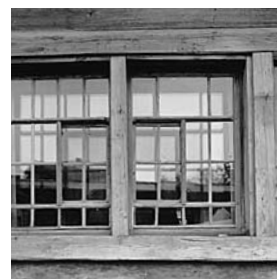
Das erhaltene Doppelfenster an der rückseitigen Bohlenständerfassade wurde zum Kastenfenster ergänzt. Zustand 1992. (Vgl. Bild oben).
