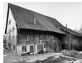
Die Nordfassade in Bohlenkonstruktion nach der Renovation. Zustand 1992.
