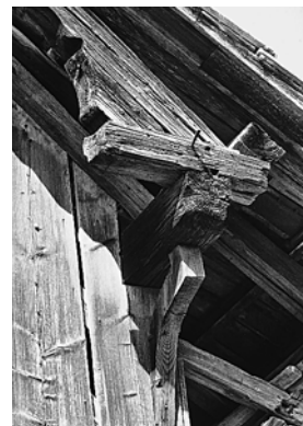
Flugsparrendreieck an der Nordostecke der Stallscheune, errichtet um 1736, vor der Rekonstruktion. Zustand 1992.
