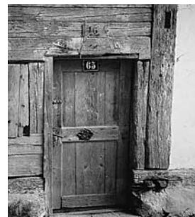
Rückseitiger Eingang zum östlichen Hausteil, rechts davon das Schwellenschloss. Zustand 1991 (Photo D. Türlér, Birmensdorf).
