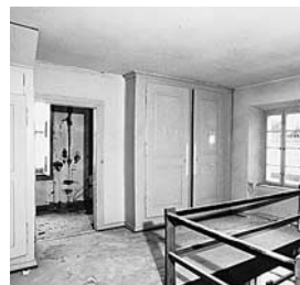
Die hölzerne Treppe im östlichen Gebäudeteil (hier im Obergeschoss), welche aus feuerpolizeilichen und statischen Gründen durch eine Stahl-/Steinkonstruktion ersetzt werden musste. Während der Renovation. Zustand 1992. (Vgl. Bild unten).
