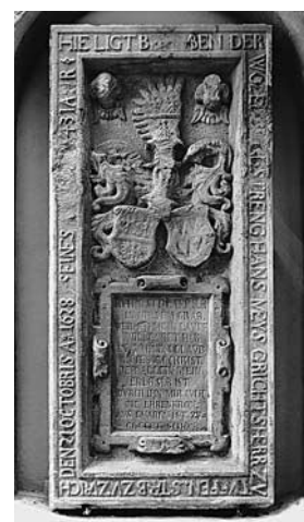
Grabplatte von Hans Meiss (1585–1628), Gerichtsherr von Teufen, an der Westseite der Kirche Rorbas. Zustand 1991.
