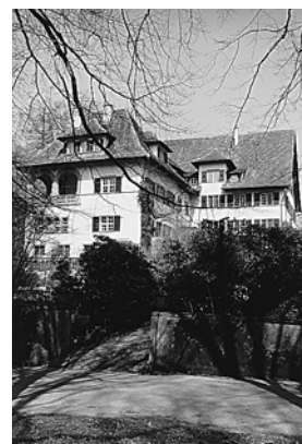
Landhaus «Bocken» von S dwesten. Links der Anbau von 1911–1913, rechts das barocke Geb u-de von 1681–1688. Zustand 1988.
