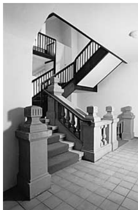
Treppenhausgestaltung 1. Obergeschoss von 1883–1884. Zustand 1992.
