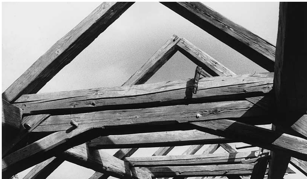
Dachstuhlkonstruktion des Speichers Vers. Nr. 829. Zustand 1992.
