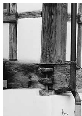
Schwellenschloss an der Südostfassade des Wohnhauses nach der Renovation. Zustand 1994.
