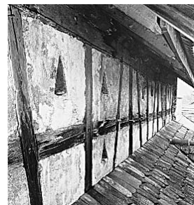
Fassadendetail mit dreieckigen Lüftungsöffnungen an der Südwestseite im 2. Obergeschoss. Zustand 1991.
