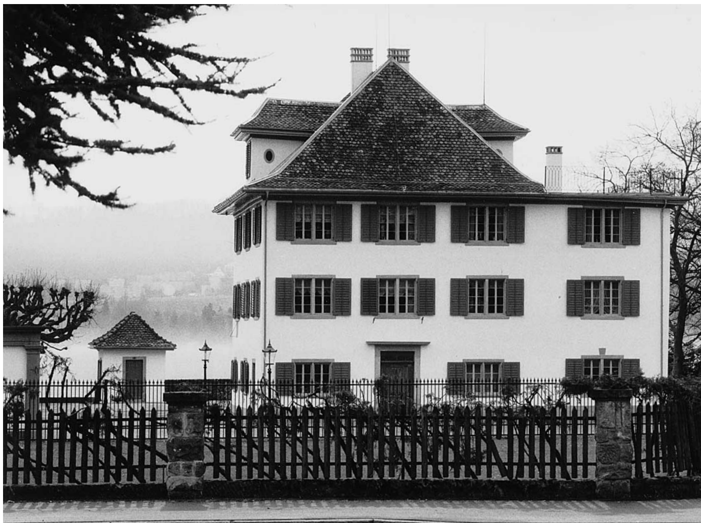
Oben: Nordfassade des Landhauses nach der Renovation. Rechts der westliche Erweiterungs- trakt. Die Kellerfenster wurden durch grössere Fenster ersetzt. Vgl. Bild rechts. Links neben dem Landhaus das ebenfalls renovierte Garten- und Badehaus. Zustand 1996.
