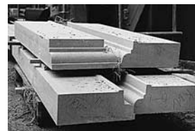
Sandstein-Werkstücke für die Rekonstruktion der Veranda. Photo 31. März 1992.
