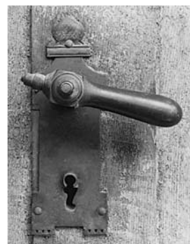
Detail vom Eingangsportal. Zustand 1992.
