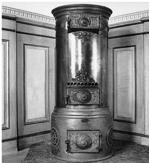
Links: Radiator der Warmwasserzentralheizung von 1895 im seeseitigen, nord-westlichen Eckzimmer des 1. Obergeschosses (vgl. Bild S. 293, links). Die Verkleidung ist vorübergehend entfernt. Zustand 1992.
