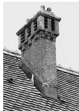
Kamin auf der südlichen Dachfläche. Zustand 1993.
