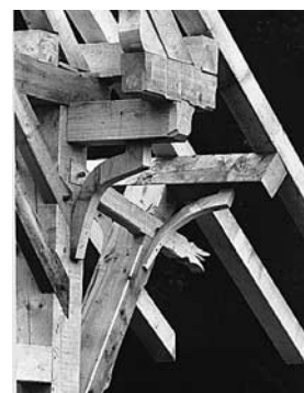
Vordachabstützung an der Nordostecke der Stallscheune, errichtet um 1736, nach der Rekonstruktion. Zustand 1992.
