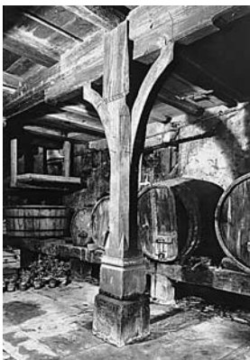
Kellerstud, dendrodatiert 1683/1684 mit Datum 1814 am Sockel. Zustand 1960.
