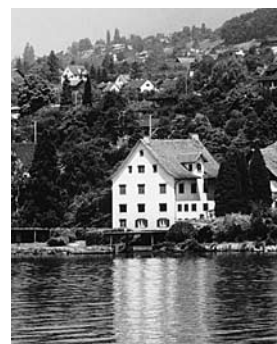
Ansicht des Landsitzes vom See aus. Zustand 1986.
