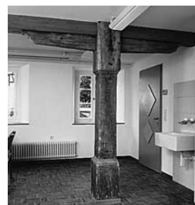
Jochsäule im Untergeschoss. Nach der Renovation. Zustand 1993.
