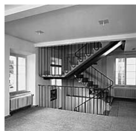
Das Treppenhaus im östlichen Gebäudeteil (hier im Obergeschoss) mit neuer Treppe in Stahl-/Steinkonstruktion, die vom Untergeschoss bis ins neu ausgebaute Dachgeschoss führt. Nach der Renovation. Zustand 1993. (Vgl. Bild oben).
