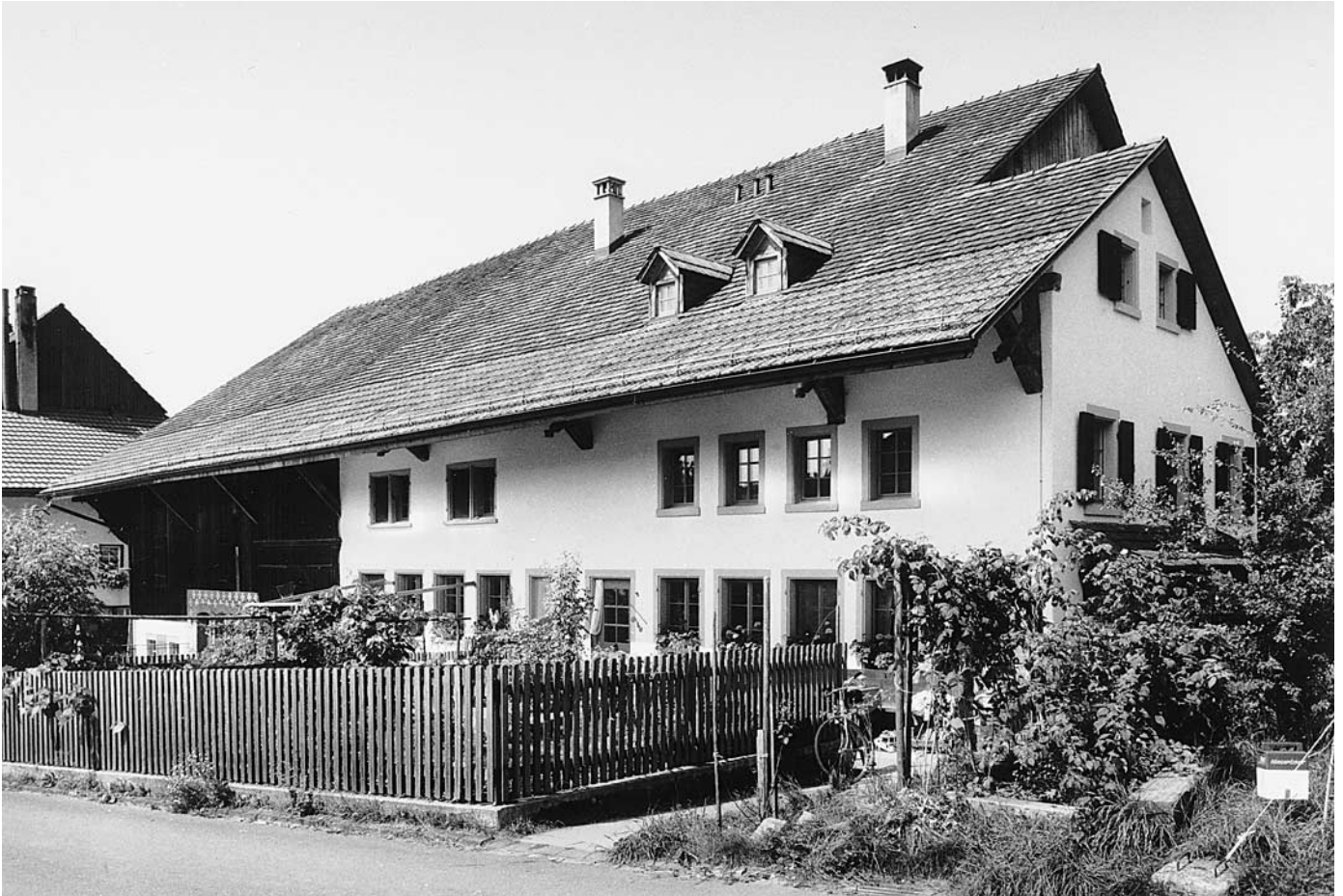
Oben: Süd- und Ostfassade nach der Renovation. Im Dachstock entstand eine 2 1/2-Zimmer-Wohnung mit neuen Lukarnen. Zustand 1996.
