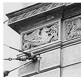
Der Fries am Mezzaningeschoss und das Sohlbankgesims sind mit dekorativen Elementen aus Terrakotta versehen, die wahrscheinlich aus der Tonwarenfabrik Schaffhausen stammen. Zustand um 1980.
