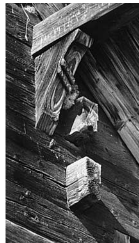
Pfettenkonsole an der Südostfassade, mit schräg laufenden Doppelwülsten, einem volkstümlichen Dekorationselement des mittelalterlichen Holzbaues. Zustand 1981.
