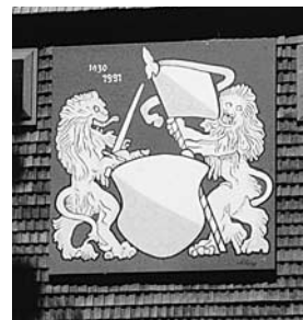
Das Kantonseblem an der Hauptfassade, bezeichnet «1930 1991». Zustand 1997.
