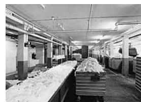
Hauptgebäude, Erdgeschoss. Spinnsaal mit Steinstützenkonstruktion von 1827–1829. Zustand 1983.
