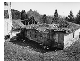
Das 1851 erbaute Badehaus im März 1977, nachdem das Walmdach unter der Schneelast eingestürzt war und bevor das ganze charakteristische Gebäude abgebrochen wurde. Vgl. Bild oben.
