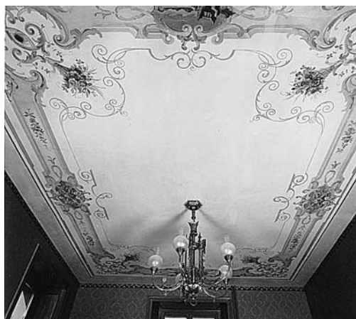
Decke im Sitzungszimmer im Erdgeschoss während und nach der Restaurierung. Zustand 1993 und 1994. Hier konnte, im Gegensatz zur Decke im Korridor, die Verlegung der bereits eingezogenen Installationen erwirkt werden. Die Bemalung wurde freigelegt und restauriert, die Fehlstellen wurden vergipst und anschliessend retuschiert.
