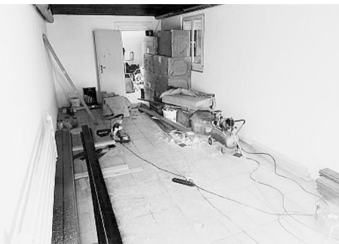
Kaum zu glauben: Aus dieser Baustelle wird bald eine bequeme Bar/Lounge.
