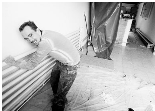
Neuer Bar-Besitzer Mario Schollenberger reinigt die Heizrohre.
