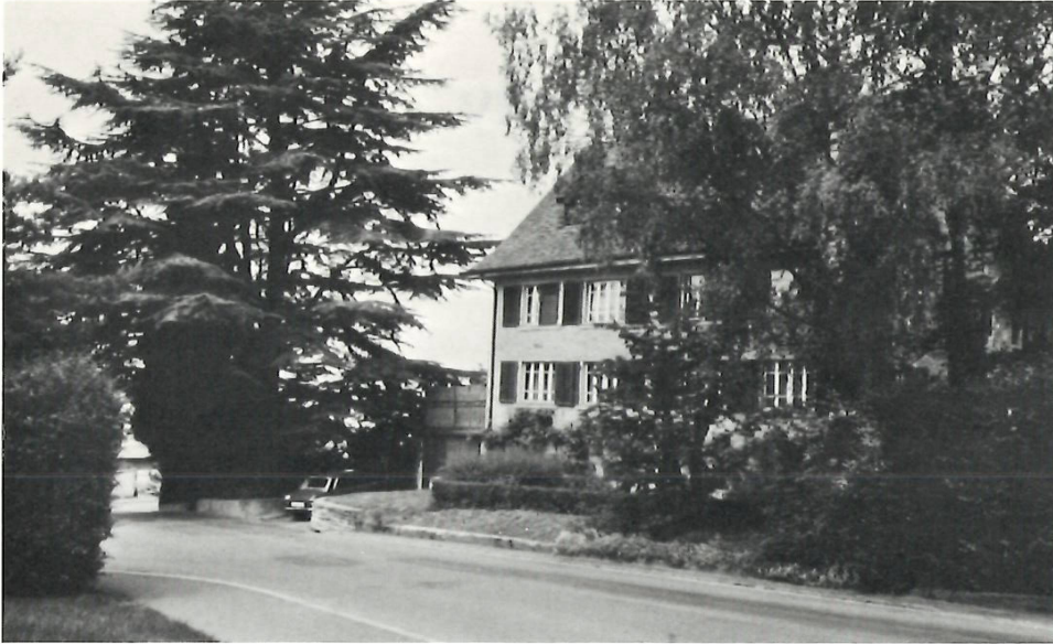
Haus Bünishof in Feldmeilen Ostseite
