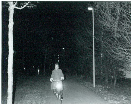
Die Radwegbeleuchtung zwischen Bisikon und Moosburg ist realisiert. (Re)
