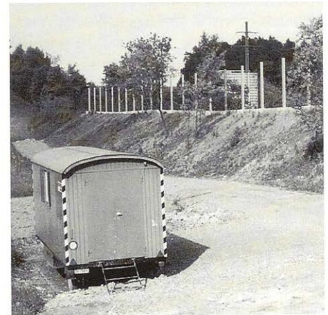
Endlich werden längs der Nationalstrasse N1 auf Brüttiseller Seite Lärmschutzwände errichtet.
