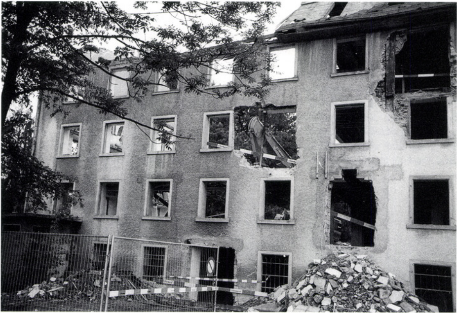
Die Abbrucharbeiten sind Ende April 2003 in vollem Gang. Die SV-Group konzentriert ihren Hauptsitz mit rund 200 Angestellten in Dübendorf.
