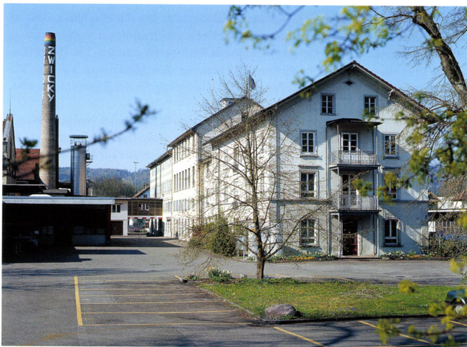
Blick von der Neugutstrasse auf das Verwaltungsgebäude, erbaut 1865. Einst diente die Liegenschaft im Vordergrund den Fabrikanten Zwicky und Burckhardt als Wohnhaus. In der Verlängerung stehen angebaut die ehemaligen Büro-, Lager- und Fabrikationsgebäude.
