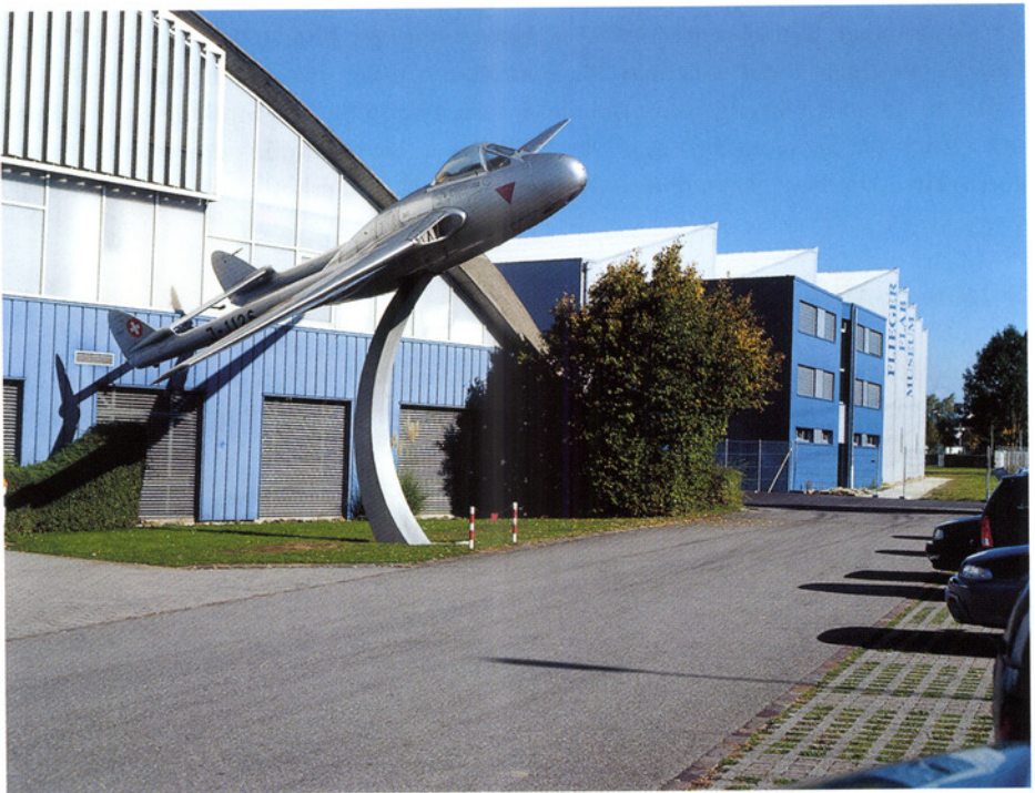
Eingangsbereich des Flieger Flab Museums. Deutlich ist rechts der im Frühjahr 2002 eingeweihte Erweiterungsbau zu erkennen, der weitgehend aus Holz gefertigt ist.
