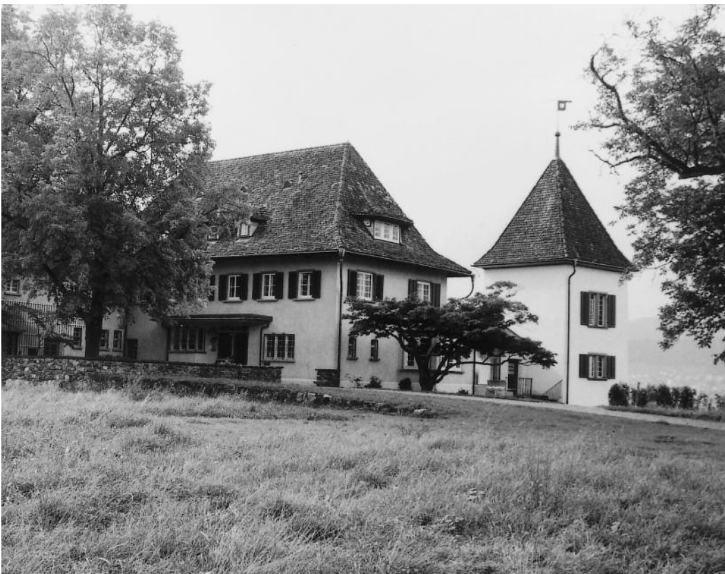
Ansicht von Norden nach Abschluss der Gesamtrestaurierung und Umnutzung. Zustand September 2008. KDP Fotoarchiv.
