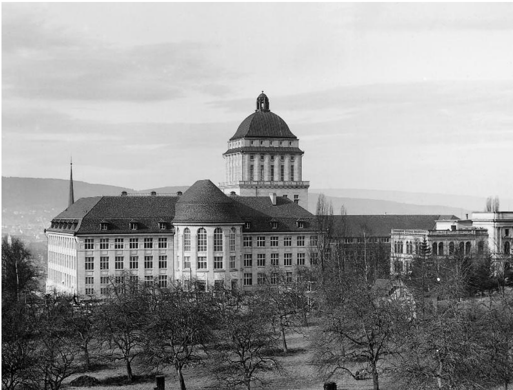
Gesamtansicht von Osten. Zustand kurz vor Bauvollendung, Februar 1914. KDP Fotoarchiv.
