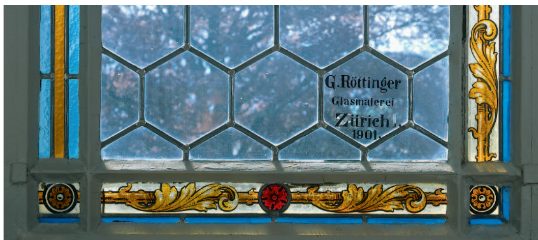
Festsaal im 1. Obergeschoss des Zentralbaus. Ausschnitt des Südwestfensters mit Bleiverglasung und Signatur. Zustand nach der Renovation, März 2009. KDP Fotoarchiv.
