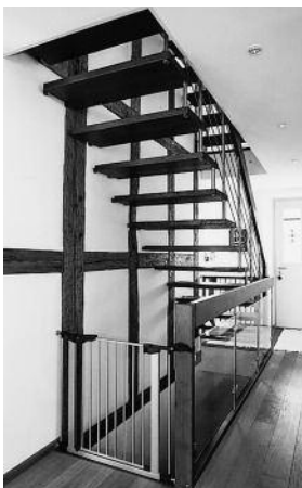
Unten: Blick in den Korridor im 1. Obergeschoss nach der Gesamtnovation. Zustand Mai 2007. KDP Fotoarchiv.
