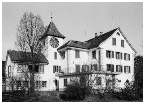
Meilen, Wohnhaus, sog. Neuer Schynhut Vers. Nr. 855, Obermeilen, Seestrasse 960. Links: Nach Renovation, Teilabbruch bzw. -neubau, Aufnahme 2008. Rechts: Gesamtansicht von Nordwesten im Vorzustand. Aufnahme 1979.
