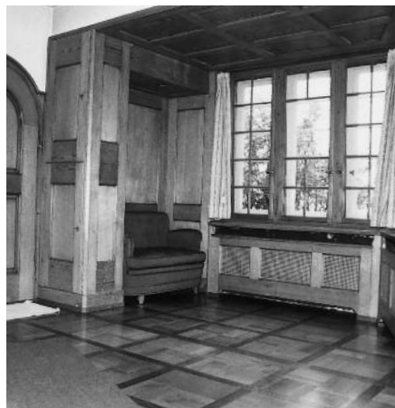
Innenräume im Erdgeschoss vor der Restaurierung. Links: Esszimmer. Rechts: Empfangszimmer. Zustand Mai 1997. KDP Fotoarchiv.
