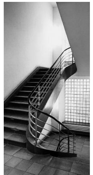
Treppenhause im Salvisberg-Bau. Zustand vor der Renovation, Januar 2002. KDP Fotoarchiv.
