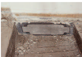
Beispiele für die Gestaltungsvielfalt der nachträglich erneuerten Graufassungen. Oben: Raum 2.3.2, Mitte: Raum 2.4.4, unten: Raum 2.4.5. Zustand während des Umbaus, Juli 2002 (oben) bzw. Dezember 2004. KDP Fotoarchiv.
