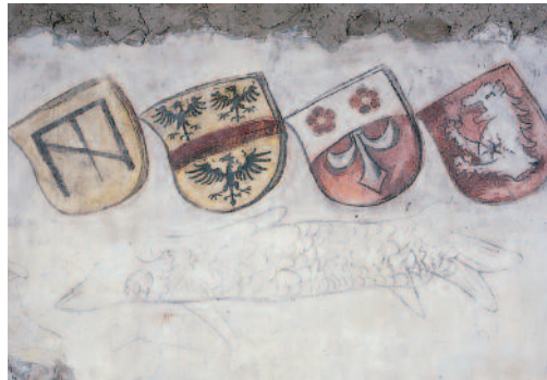
Wappenfries mit den Wappen der Landvögte Suter, Meiss, Göldi, Grebel, darunter sekundäre Graphitmalerei. Links: Zustand vor der Restaurierung, April 2005. Rechts: Zustand nach der Restaurierung, November 2006. KDP Fotoarchiv.
