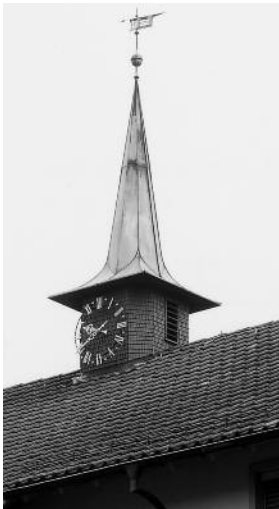
Der markante Dachreiter mit Turmuhr und Wetterfahne vor der Demontage, Zustand Juni 2003. KDP Fotoarchiv.
