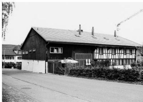
Dietlikon, Ehem. Bauernhaus Vers. Nrn. 124, 125 mit Schopf Vers. Nr. 126 und Speicher Vers. Nr. 128, Riedenerstrasse 1, 3. Nach der Gesamtrenovation. Links: Teilansicht von Westen mit Speicher und Umgebung. Rechts: Gesamtansicht der Südfassade, Aufnahmen 2008.
