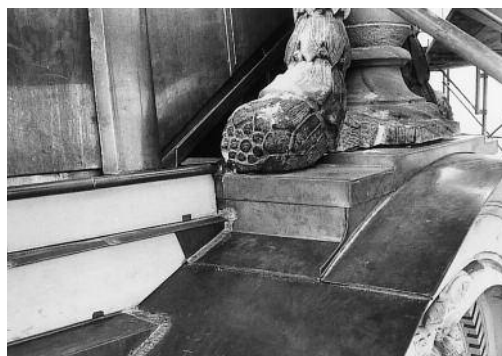
Abdeckung in Kupferblech oberhalb des westlichen Zifferblatts. Zustand vor bzw. nach der Renovation, Januar bzw. November 2005. KDP Fotoarchiv.
