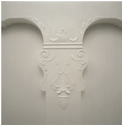
Links: Ausschnitt der Deckenstuckaturen im Verkaufsraum des Heimatwerks. Rechts: Verkaufsraum des Heimatwerks mit der freigelegten Stuckbalkendecke gegen Süden. Zustand nach der Renovation, November 2008. KDP Fotoarchiv.
