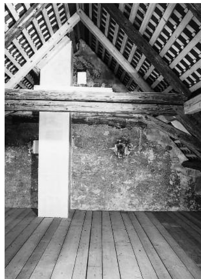
Links: Südlicher Speicher-raum im 1. Obergeschoss mit Treppenaufgang ins Dachgeschoss. Rechts: Südlicher Dachraum mit gemauerter Giebelfassade. Zustand nach der Renovation, Juni 2005. KDP Fotoarchiv.
