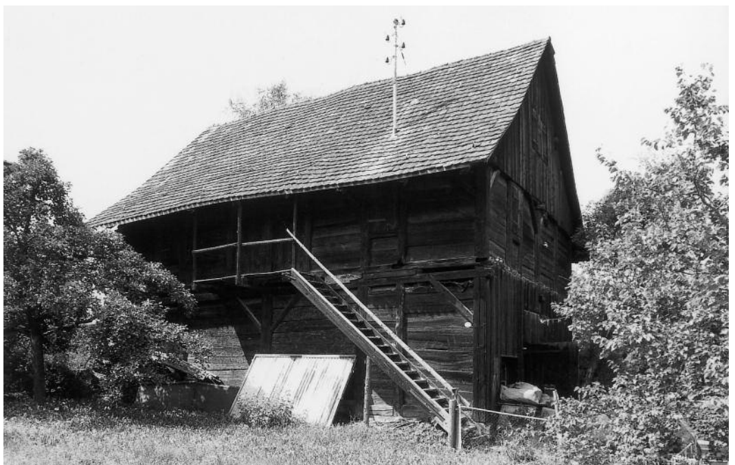
Gesamtansicht des Speicher- und Trottbgebäudes von Nordosten. Zustand August 1998. KDP Fotoarchiv.
