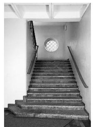
Treppenaufgang vom Unter- ins Erdgeschoss mit zeittypischem Rundfenster. Zustand Juni 2003. KDP Fotoarchiv.
