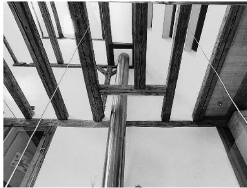
Links: Vorplatz im 1. Obergeschoss, «Lichtkamin» mit Glasbrüstung. Rechts: Ausblick von der Wohnküche gegen den «Lichtkamin». Zustand nach der Renovation, Dezember 2005. KDP Fotoarchiv.
