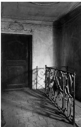
Treppenhaus im 5. Obergeschoss. Zustand um 1960. KDP Fotoarchiv.
