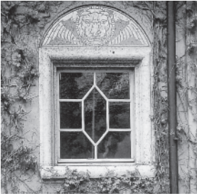
Fensterchen mit Sgraffitodekoration von Heinrich Appenzeller an der Südwestfassade des Aufbahrungsgebäudes. Zustand vor der Renovation, April 2003. KDP Fotoarchiv.
