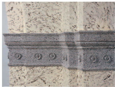
Hörsaal im 1. Obergeschoss. Ausschnitte der wiederhergestellten Wandgliederung mit Mäanderbändern und Pilasterkapitellen nach Befund. Zustand Mai 2006. KDP Fotoarchiv.
