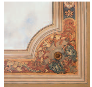
Eckausschnitt eines der drei restaurierten Deckenfelder. Zustand März 2010. KDP Fotoarchiv.
