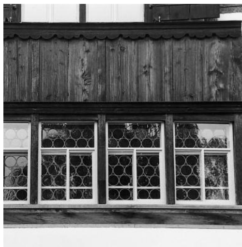
Links: Ausschnitt aus der Südwestfassade mit dem Reihenfenster der Stube 0.22. Zustand 1971. Rechts: Ausschnitt aus der Südwestfassade mit dem Reihenfenster der Stube 0.22. Zustand nach der Restaurierung, September 2006. KDP Fotoarchiv.
