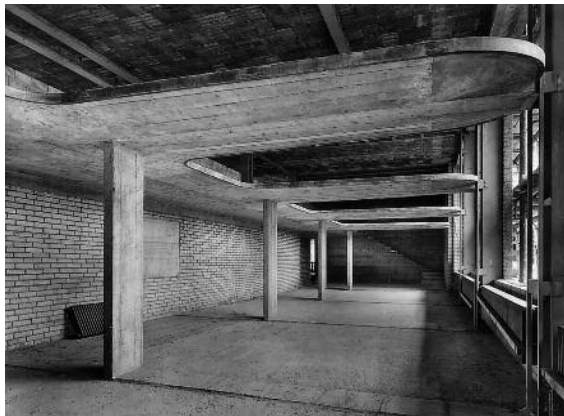
Links: Laborraum im Salvisberg-Bau mit Galerien. Zustand 18. April 1936. Rechts: Teilansicht der Stahlskelettkonstruktion des Salvisberg-Baus. Zustand 16. Oktober 1935. KDP Fotoarchiv.
