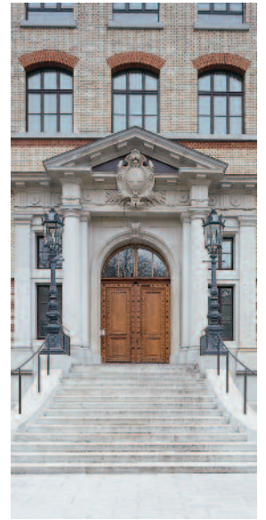
Monumentaler Haupteingang an der Westfassade. Zustand nach der Renovation, April 2006. KDP Fotoarchiv.
