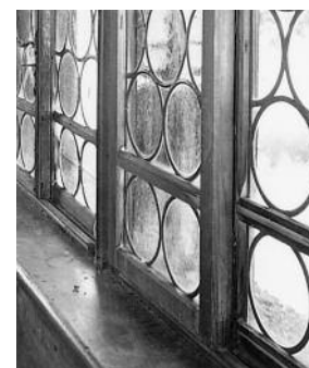
Unten: Schiebefenster mit Butzenverglasung in der Stube 0.22. Zustand vor der Restaurierung, Juni 2004. Ganz unten: Schiebefenster mit Butzenverglasung in der Stube 0.22. Zustand nach der Restaurierung, September 2006. KDP Fotoarchiv.
