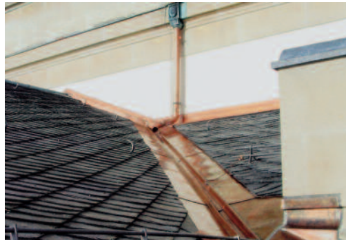
Links und rechts: Teilsichten der neuen Schieferendeckung mit den ersetzten Dachwasserinstallationen in Kupferblech. Zustand vor Abschluss der ersten Renovationsetappe, November 2005. KDP Fotoarchiv.
