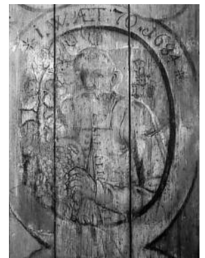
Gang 1.2. Porträt des siebzigjährigen Jos Wunderli an der Treppenuntersicht. Zustand 1986. KDP Fotoarchiv.
