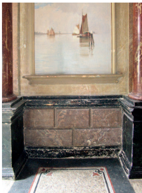
Ausschnitte mit Terrazzoboden, Sockelpartie und Seelandschaften. Zustand vor bzw. nach Abnahme der Anstriche, 2006. Dok. 7.
