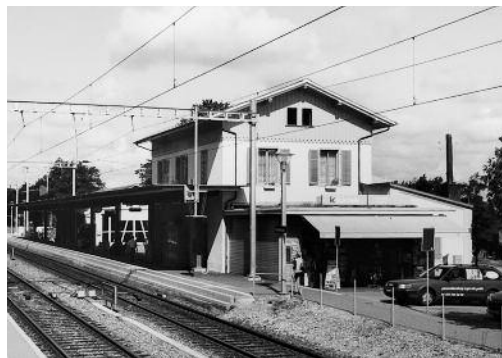
Links: Andelfingen, Wohnhaus, ehem. Steinmühle Vers. Nr. 126, Schlossgasse 33. Nach der Aussenrenovation, Aufnahme 2008.
