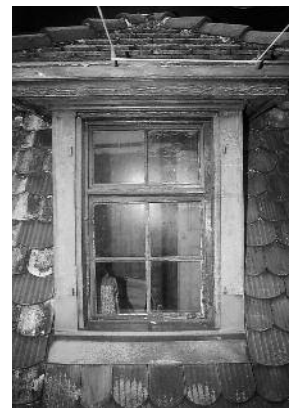
Oben: Südseitige Giebel-lukarne aus der Bauzeit. Zustand nach der Restaurierung, September 2006. KDP Fotoarchiv. Unten: Einziges erhaltenes Originalfenster. Zustand 2002. Dok. 4.
