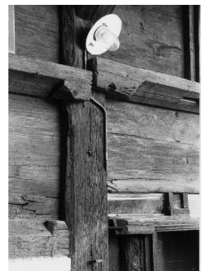
Teilansicht von Wandständer und Brüstungsriegeln an der Nordwestfassade des Wohnteils. Zustand Februar 1992. KDP Fotoarchiv.
