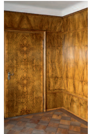
Ehem. Wohnzimmer im Erdgeschoss. Raumhohes Täfer mit Wurzelmaserierung sowie Verbindungstür zum früheren Empfangszimmer. Zustand nach der Restaurierung, März 2004. KDP Fotoarchiv.
