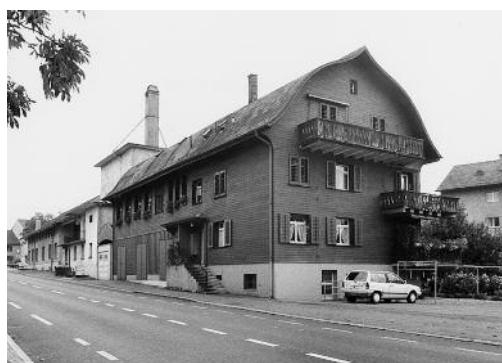
Links: Dürnten, Wohnhaus, ehem. Bauernhaus Vers. Nr. 554, Unterdorf, Riegelhausweg 14. Nach der Dachsanierung, Aufnahme 2008.
