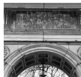
Inskriptionsplatte an der Rückseite des Torbaus: «Erbaut nach Bundesbeschluss vom 17. Dezember 1883 in den Jahren 1884–1886 – Architekten Bluntschli und Lasius». Zustand vor der Renovation, Januar 2002. KDP Fotoarchiv.
