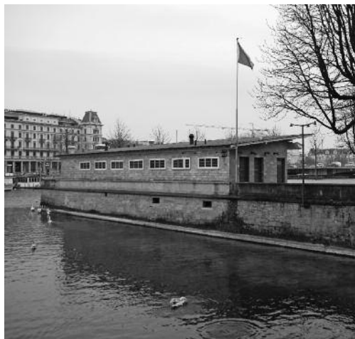
Links: Mauerabschnitt und Wirtschaftsgebäude von Nordosten. Zustand nach der Sanierung der Ufermauer und der Brüstung, März 2005. Rechts: Wirtschaftsgebäude von Nordwesten. Zustand Februar 2010. KDP Fotoarchiv.
