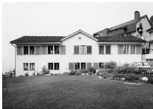
Links: Meilen, Güterschuppen Vers. Nr. 480 der Bahnhofanlage SBB, Dorfstrasse bei 113. Vor dem Abbruch zugunsten des Busbahnhofs, Aufnahme 2004.
