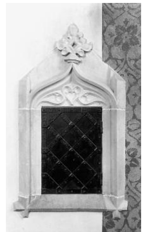
Sakramentshäuschen aus der Bauzeit in der Mittelapsis; rechts die freigelegte und restaurierte Ausmalung von 1925 mit Damastmuster. Zustand April 2006. KDP Fotoarchiv.
