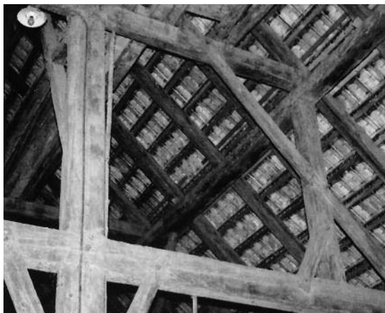
Links: Teilansicht des Dachstuhls über der Tenne. Zustand 2004. Dok. 5, S. 16. Rechts: Nördlicher Hausteil. Stubenkachelofen im Erdgeschoss. Der Ofen zeigt eine ältere Sitzkunst von 1787 in Kombination mit einem Ofenkörper aus dem frühen 19. Jahrhundert. Zustand Dezember 1965. KDP Fotoarchiv.
