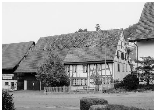
Weiningen, Bauernhaus Vers. Nr. 37, Oberdorf, Regensdorfstrasse 3. Zustand vor dem Abbruch. Links: Ansicht von Norden mit Ökonomieteil. Rechts: Ansicht von Osten, Aufnahmen 2004.
