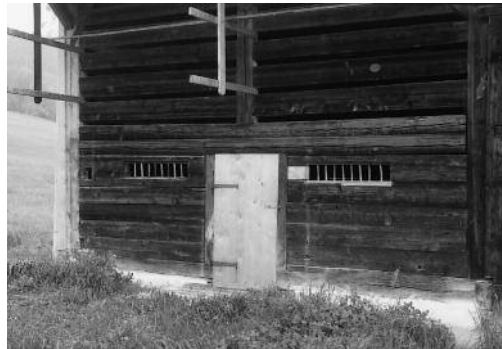
Oben links: Hohlziegeldepot vor der Nordwestfassade. Oben rechts: Südöstliche Stallfront mit ersetzter Türe. Unten: Gesamtansicht von Südosten. Zustand nach der Instandstellung, Mai 2006. KDP Fotoarchiv.
