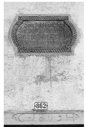
Inschrifttafel an der 1803 in Massivmauerwerk erneuerten südlichen Giebelfassade; am Türsturz die entsprechende Jahreszahl mit den Initialen «C H». Zustand Mai 1965. KDP Fotoarchiv.
