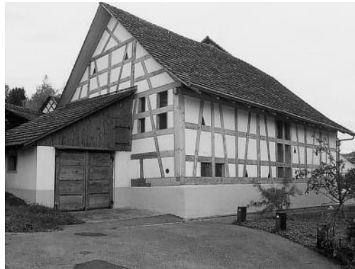
Links und rechts: Trotte. Zustand vor und nach der Sanierung, Mai 2004, bzw. Oktober 2005. KDP Fotoarchiv.
