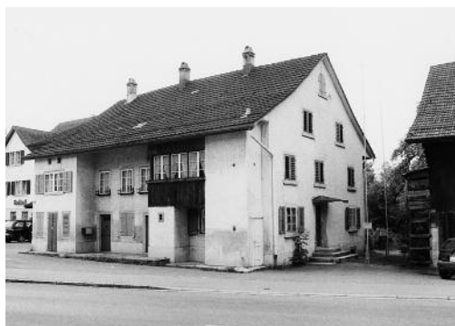
Hinwil, Doppelwohnhaus und Scheune Vers. Nrn. 1221, 1222 und 1220, Zürichstrasse 1, 3. Vor dem Abbruch. Links: Südwestfassade, Aufnahme 2005. Rechts: Gesamtansicht von Norden, Aufnahmen 2005.
