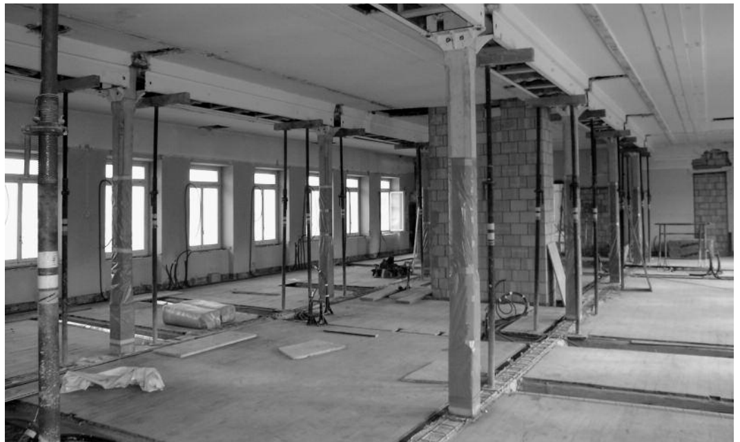
Ehem. Fabrikgebäude Vers. Nr. 182. Früherer Produktionsraum mit Stützenraster. Zustand während der Renovation, April 2006. KDP Fotoarchiv.
