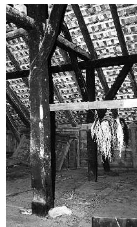
Teilansicht des Dachraums im ehemaligen Bauernhaus; ursprüngliche rauchgeschwärzte Hochstudkonstruktion (1506d) über dem Wohnteil. Zustand August 1998. KDP Fotoarchiv.
