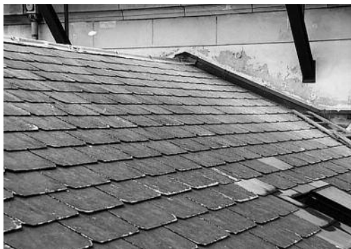
Links: Ausschnitt der Eterniteindeckung des südöstlichen Kreuzarmes. Rechts: Ausschnitt der Kupferblecheindeckung der Kuppel unterhalb der Laterne. Zustand vor der Renovation, Januar 2005. KDP Fotoarchiv.
