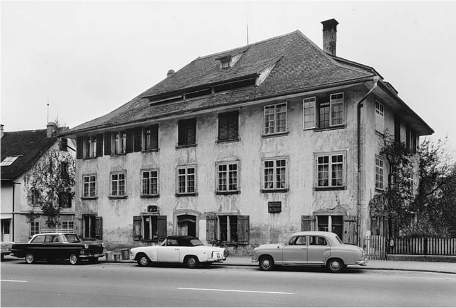
Kloten, Haus «Zur Gerbe». Zustand am 3. November 1961 (oben) und Ersatzbau am 6. Mai 1971 (unten). Das Haus wurde nach Brand 1779 für Erhard Sulzer neugebaut und diente bis 1904 als Gerbebetrieb. Abbruch 1969. Es war ein selten gut erhaltenes Beispiel eines herrschaftlich ausgestatteten Gewerbesitzes aus dem ancien régime, an dessen Dachgeschoss auch noch die gewerbliche Nutzung ablesbar war (als Lüftungsschlitze des Lagerraums dienende Schlepplgaube). Zur Wiederverwendung wurden Öfen, Täfelteile und Türen ausgebaut, die reich stuckierte Salondecke des 2. Obergeschosses wurde 1972–1973 in der Gerichtsstube des Schlosses Kyburg nach Abgüssen und Photos rekonstruiert. Vgl. 6. BerZD 1968/69, Zürich 1973, S. 74–76 sowie 7. BerZD 1970–1974, II. Teil, Zürich 1978, S. 101–103. Beispiele aus der vom Denkmalpfleger Dr. Walter Drack angelegten Bildzusammenstellung über «Denkmalpflege-Musterbeispiele: Profanbauten» bzw. «Abbrüche».
