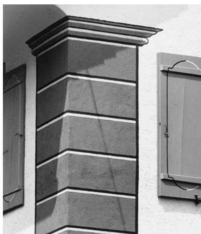
Mettmenstetten, Buchstock. Gemalter Eckpilaster nach der Restaurierung 1984.
