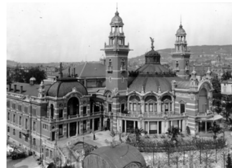
Abbruch 1937: Der alte Tonhalle-Pavillon (Foto: BAZ_054582, Ludwig Macher)
