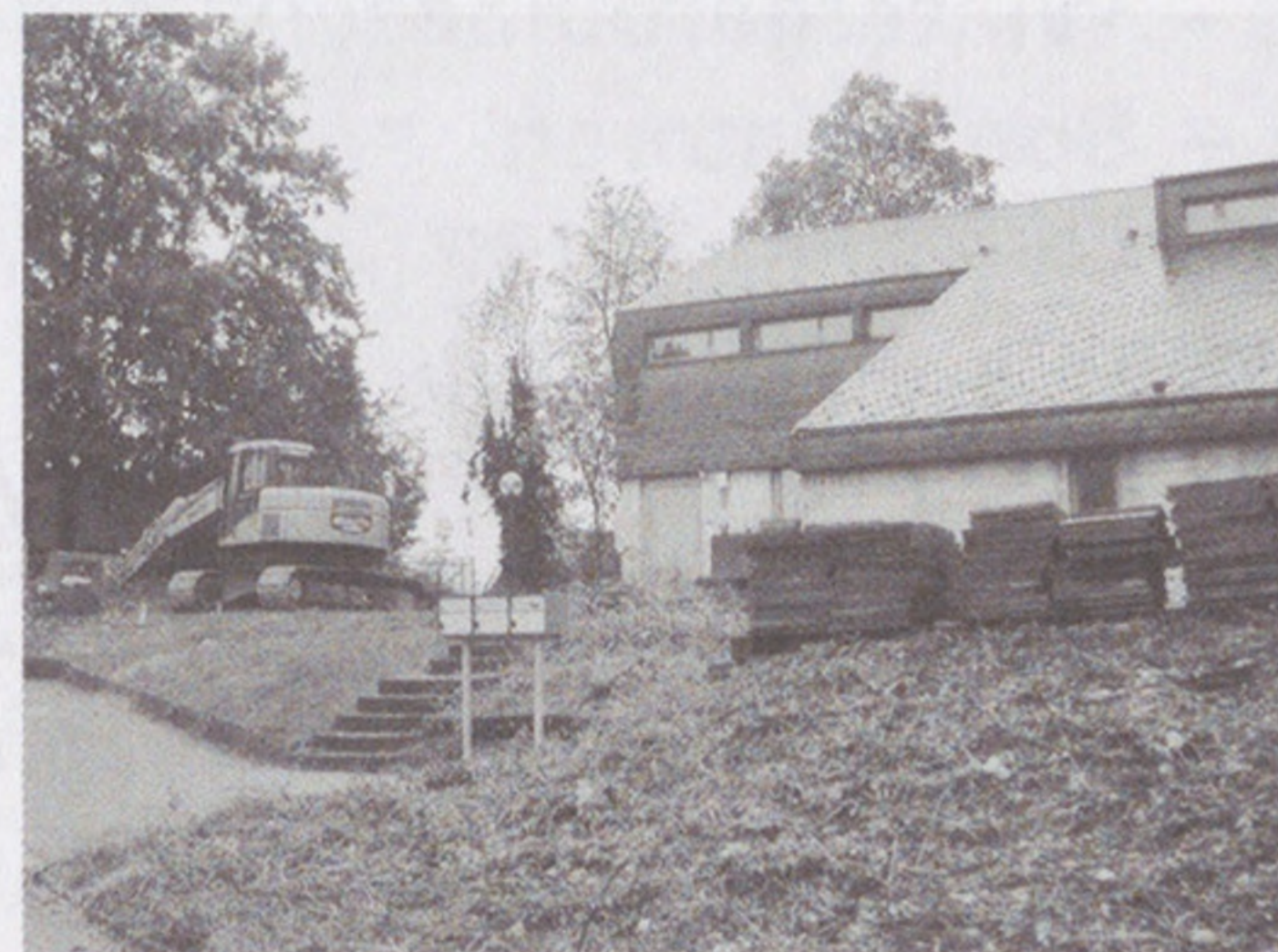
Die zusätzlichen Parkplätze kommen auf der oberen (linken) Seite des Gebäudes zu liegen. (Foto: gw)
