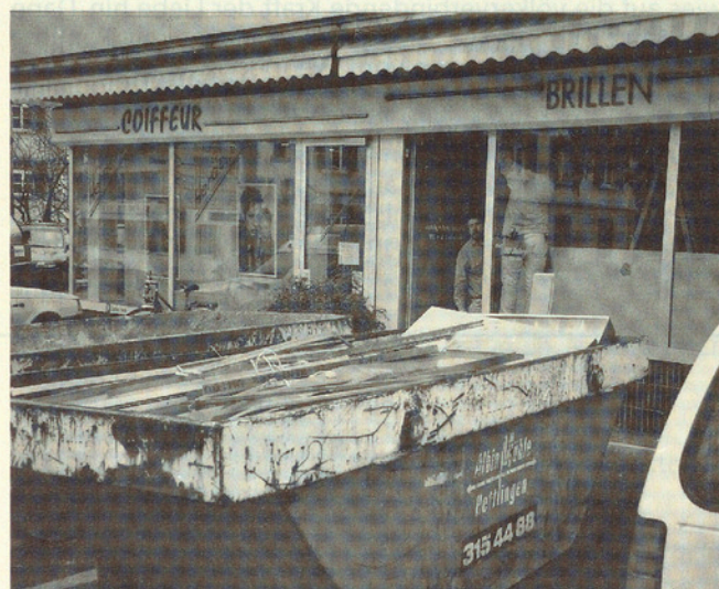
Der Umbau beginnt ...!
