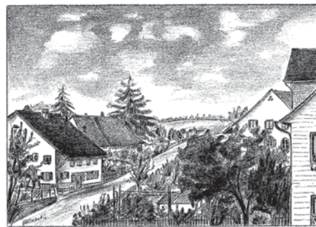
ob. Dorfstrasse Gröschtl
