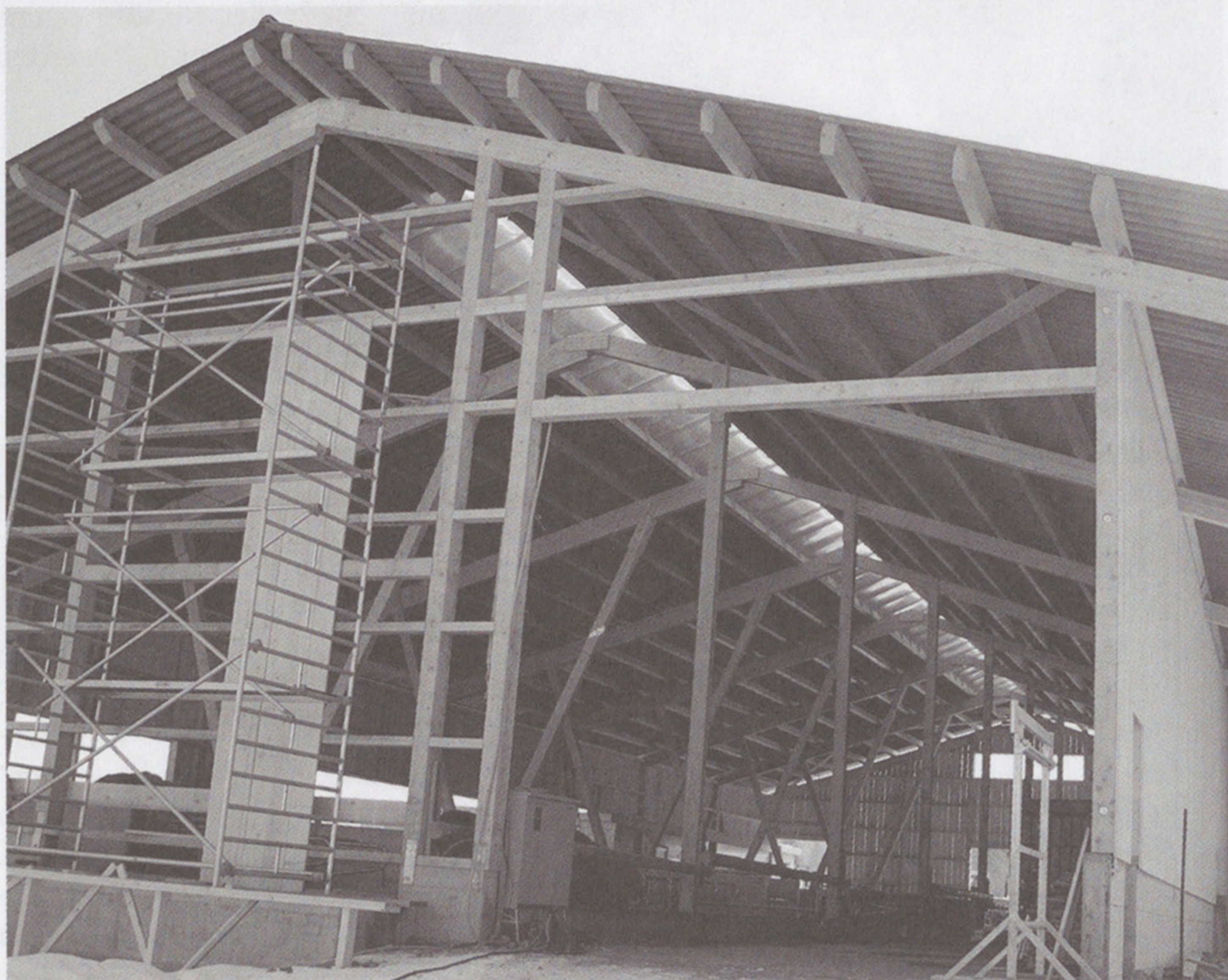
Der neue Stall mit freiem Auslauf für die Tiere von Bauer Keller. In Kürze werden noch die fehlenden Wände montiert. (Fotos: pi)
