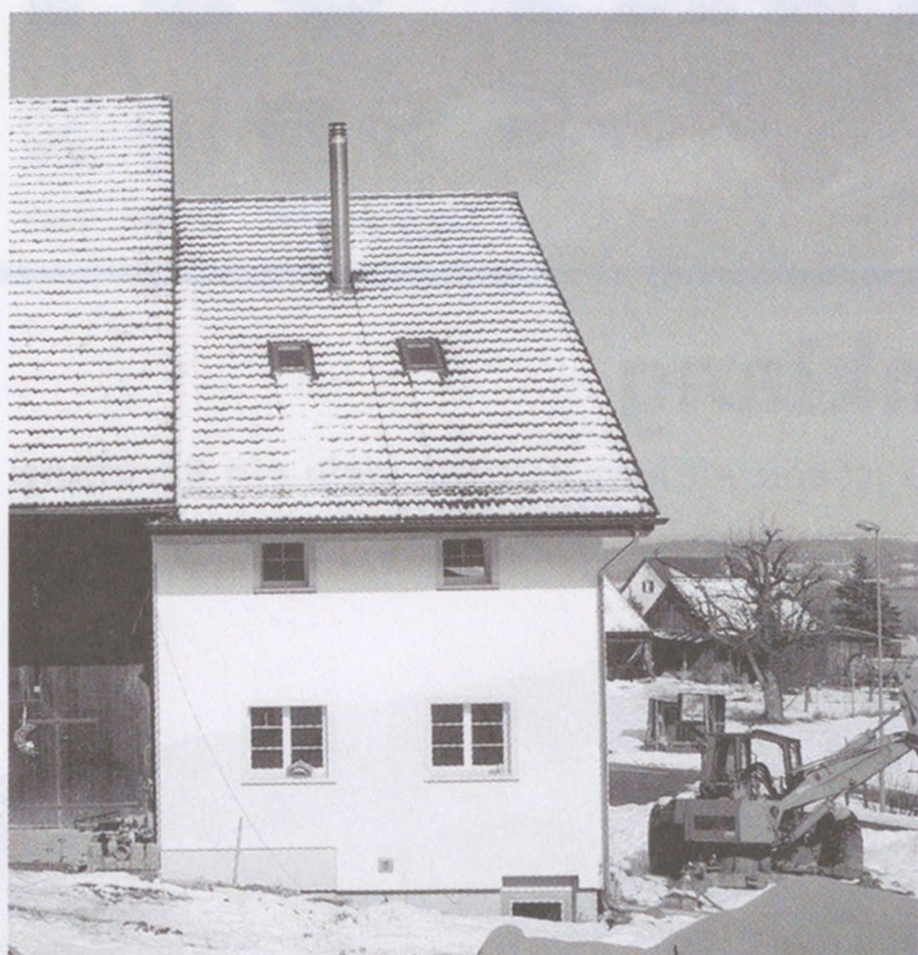
Beim Umbau des Bauernhauses musste der rechte Teil komplett neu erstellt werden. Rechts der kleine Bagger von Bauer Keller.
