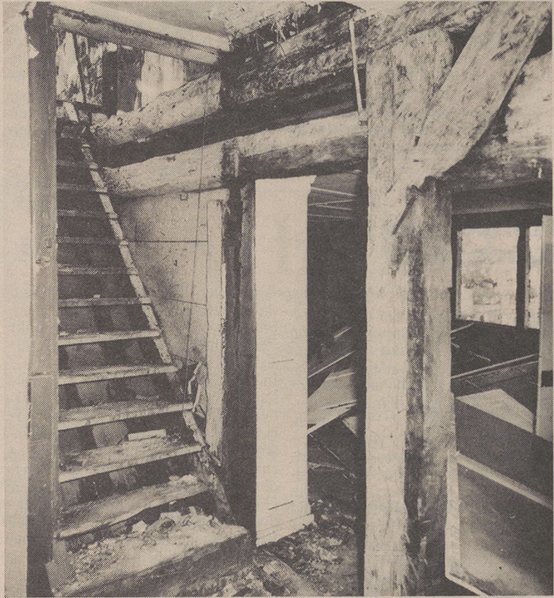
Abbildung 13 Obere Treppe im hinteren Haus, Aufgang zum Dachraum, daneben ist ein Ständer mit Kopfstrebe zu sehen.
