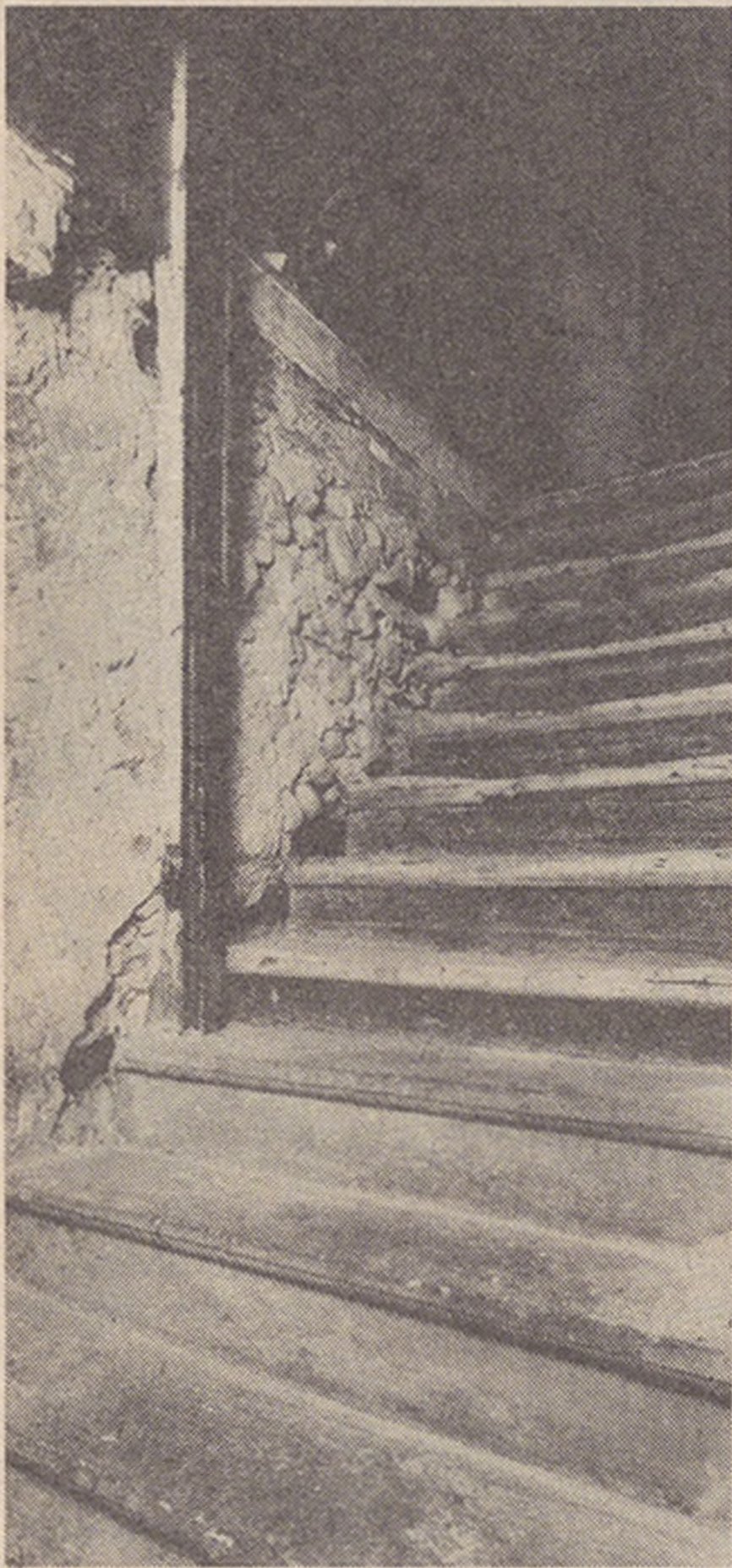
Abbildung 12 Blocktreppe im vorderen Haus vom Erdgeschoss zum ersten Obergeschoss, rechts angelehnt an die Mauer des ältesten Baues, diese im Bild nicht sichtbar, abgebildet eine Mauer aus der Bauphase 3 (1538), vergleiche Pläne Abb. 5 (S. 21) Abb. 10 (S. 27)
