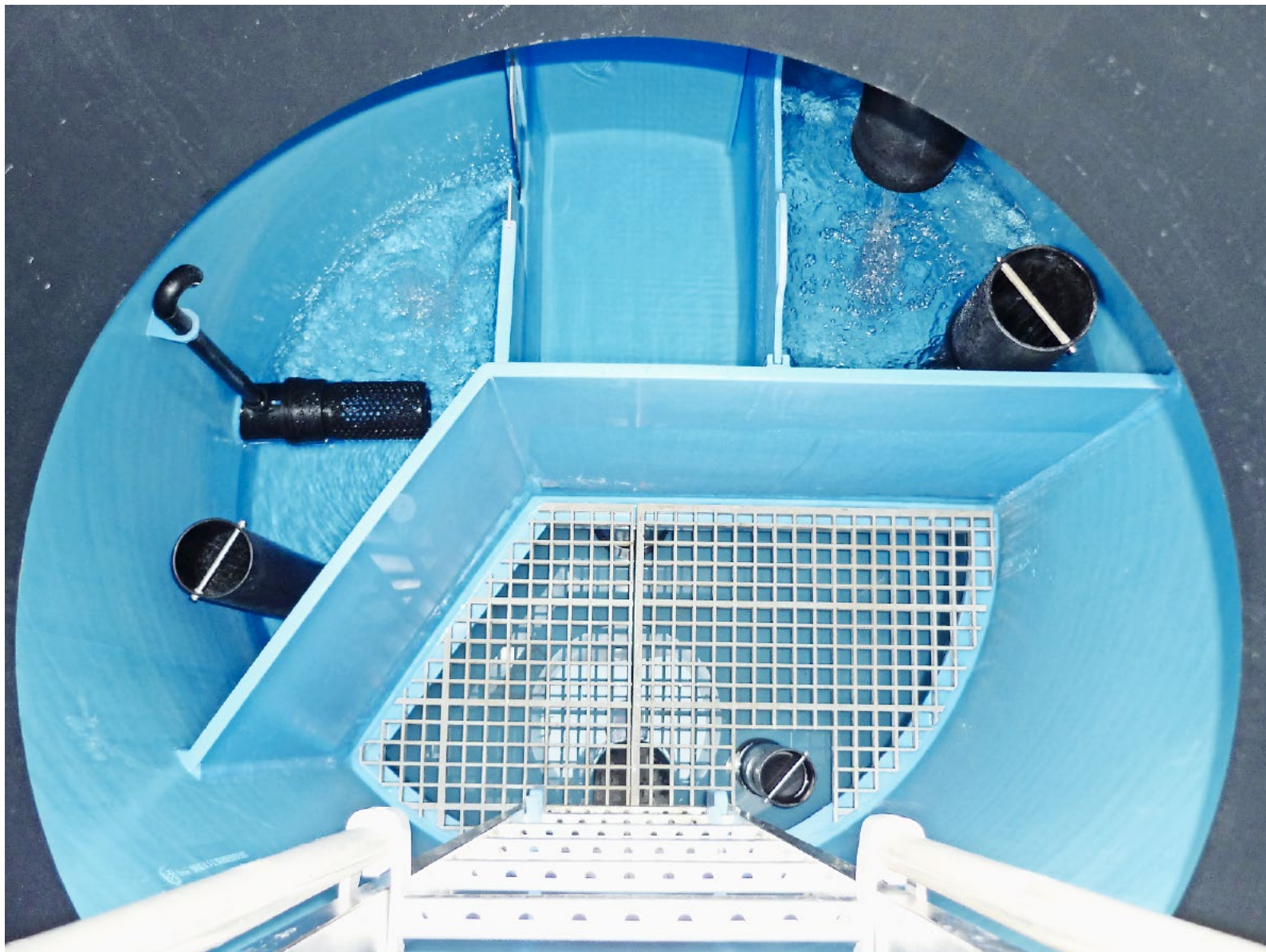
Einblick Brunnenstube Quellen Aesch, an der Wassbergstrasse
