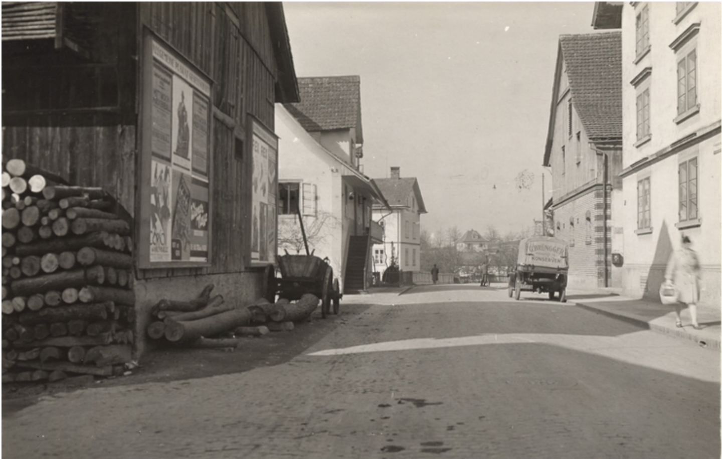
Zur Mutschelle. Mutschellenstrasse 134 und 126 sowie (rechts) 143. Mittig Thujastr. 17. 1928. Baugeschichtliches Archiv Zürich.
