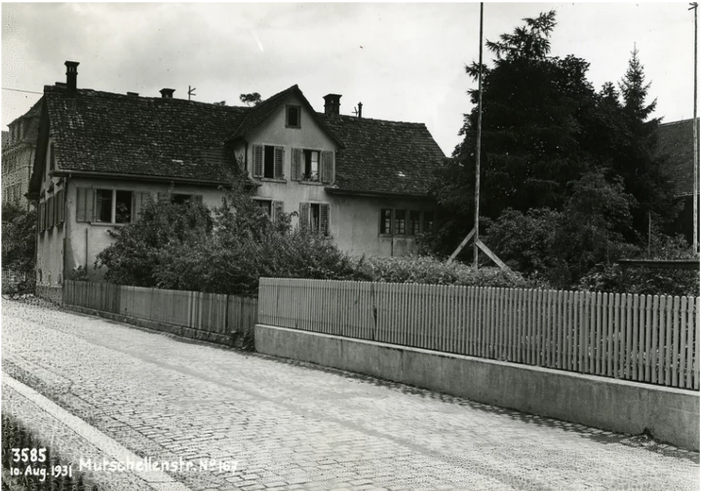
Mittlere Mutschelle. Mutschellenstrasse 167. 1931. Foto: Tiefbauamt. Baugeschichtliches Archiv Zürich.
