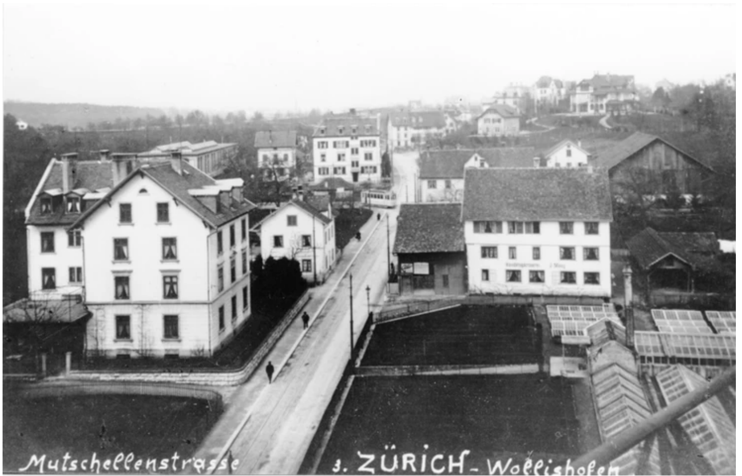
Mutschellenstrasse. Ohne Fotograf und Jahr. Baugeschichtliches Archiv Zürich.
