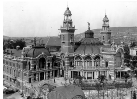
Abbruch 1937: Der alte Tonnhalle-Pavillon (Foto: BAZ_054582, Ludwig Macher)
