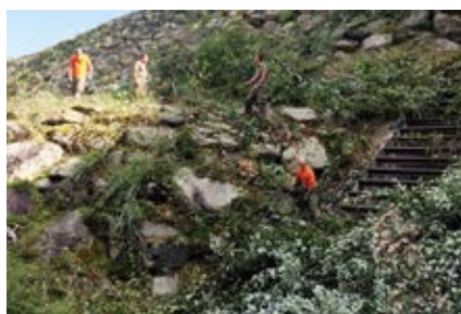
Das Lawinenauffangbecken wird von Bäumen und Sträuchern befreit
