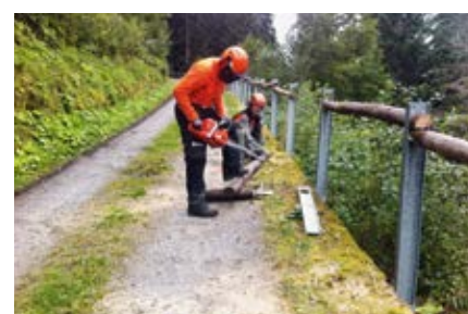
Oberhalb von Zignau werden die Handläufe erneuert
