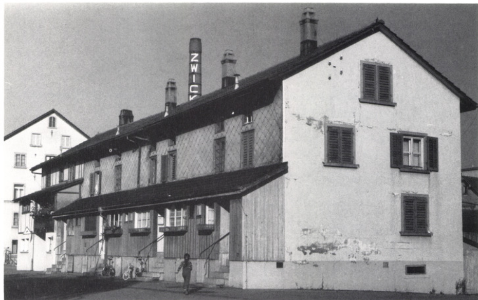
Der Besitzer der Seidenzwirnerie im Neugut bemühte sich schon sehr früh, die Lage seiner Arbeiter durch praktische Hilfeleistung zu verbessern. 1845 wurde mit dem Bau des sogenannten «alten Kosthauses» begonnen, das wie unser Bild aus dem Jahre 1979 zeigt, heute noch benützt wird.
