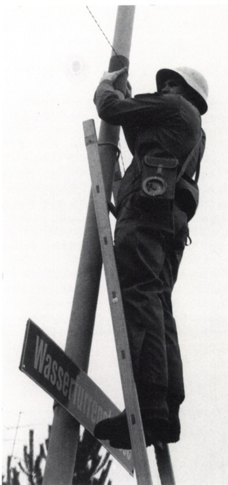
Ein Angehöriger des Übermittlungsdienstes beim Verlegen einer feldmässigen Telefonleitung.
