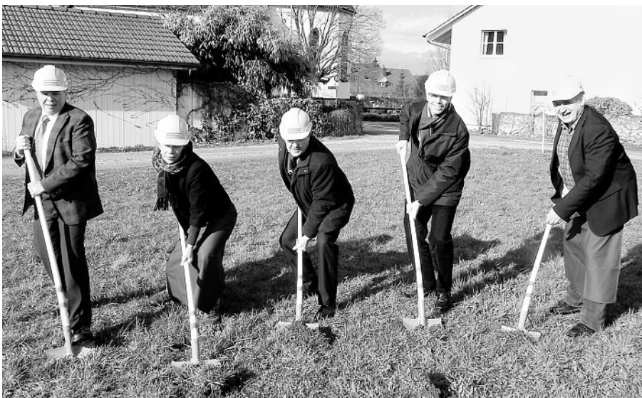
Pfr. K. Gautschi, Pfr. K. Huber, Karl Walder, Bruno Sauter und Pfr. H. Wulf beim Spatenstich (v.l.n.r.).
