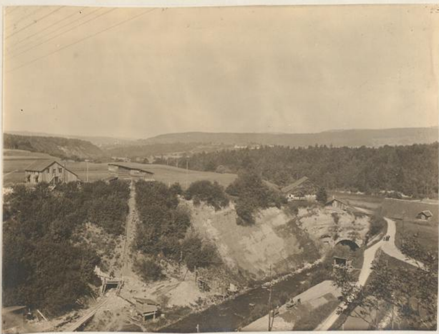
Blick von der Eisenbahnbrücke (2. Bild)
