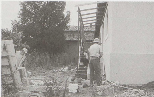
Bauarbeiten an der Arztpraxis in Chendu.
