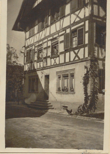
Durch modernen Unterbau verschandelt.
